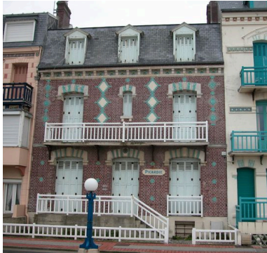
Vue d'ensemble depuis l'esplanade. Phot. Elisabeth Justome IVR22_20038005263NUCA
