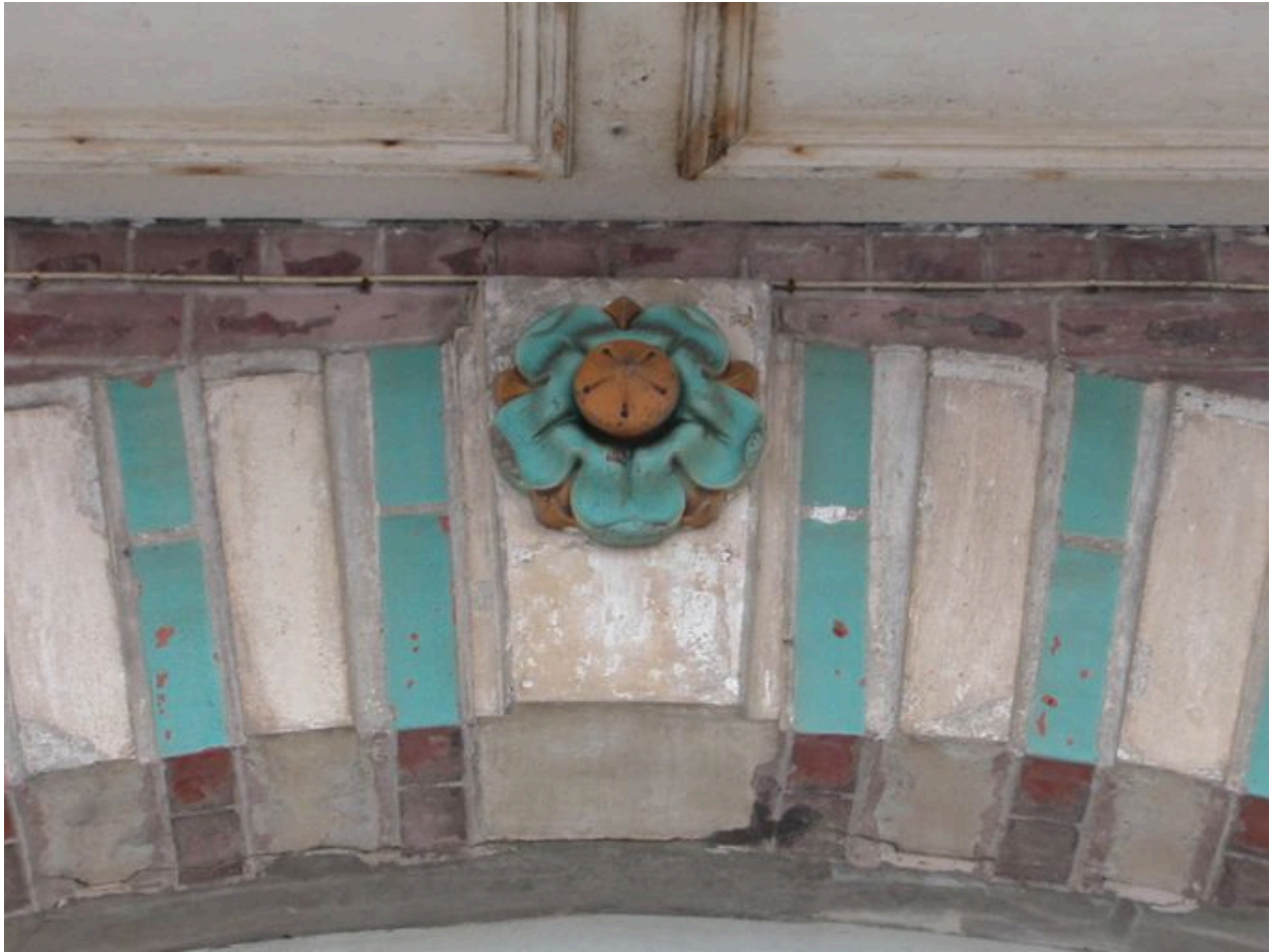
Détail de la rosace en céramique ornant la plate-bande de la baie centrale, au rez-de-chaussée.
