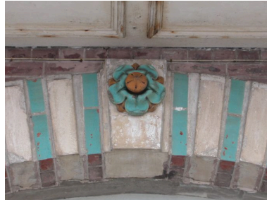
Détail de la rosace en céramique ornant la plate-bande de la baie centrale, au rez-de-chaussée. Phot. Elisabeth Justome IVR22_20058003169NUCA
