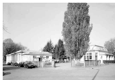
École maternelle, vue générale en 2001. Phot. Pierre Thibaut IVR31_20015901151V
