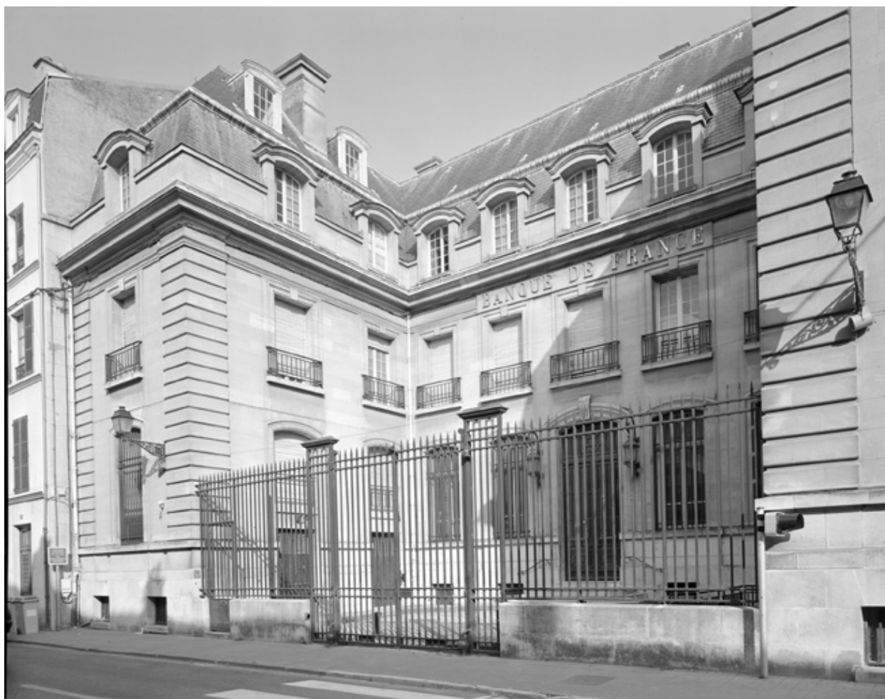
Elévation sur la rue Carnot.
