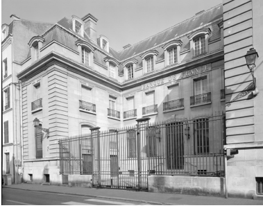
Elévation sur la rue Carnot. Phot. Thierry Lefébure IVR22_19940201184V
