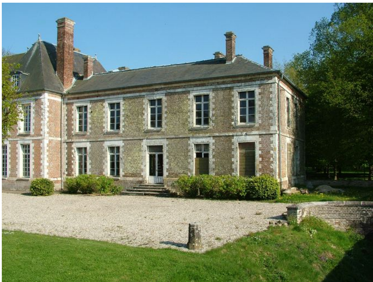
Corps de logis moderne, vue sur cour.
