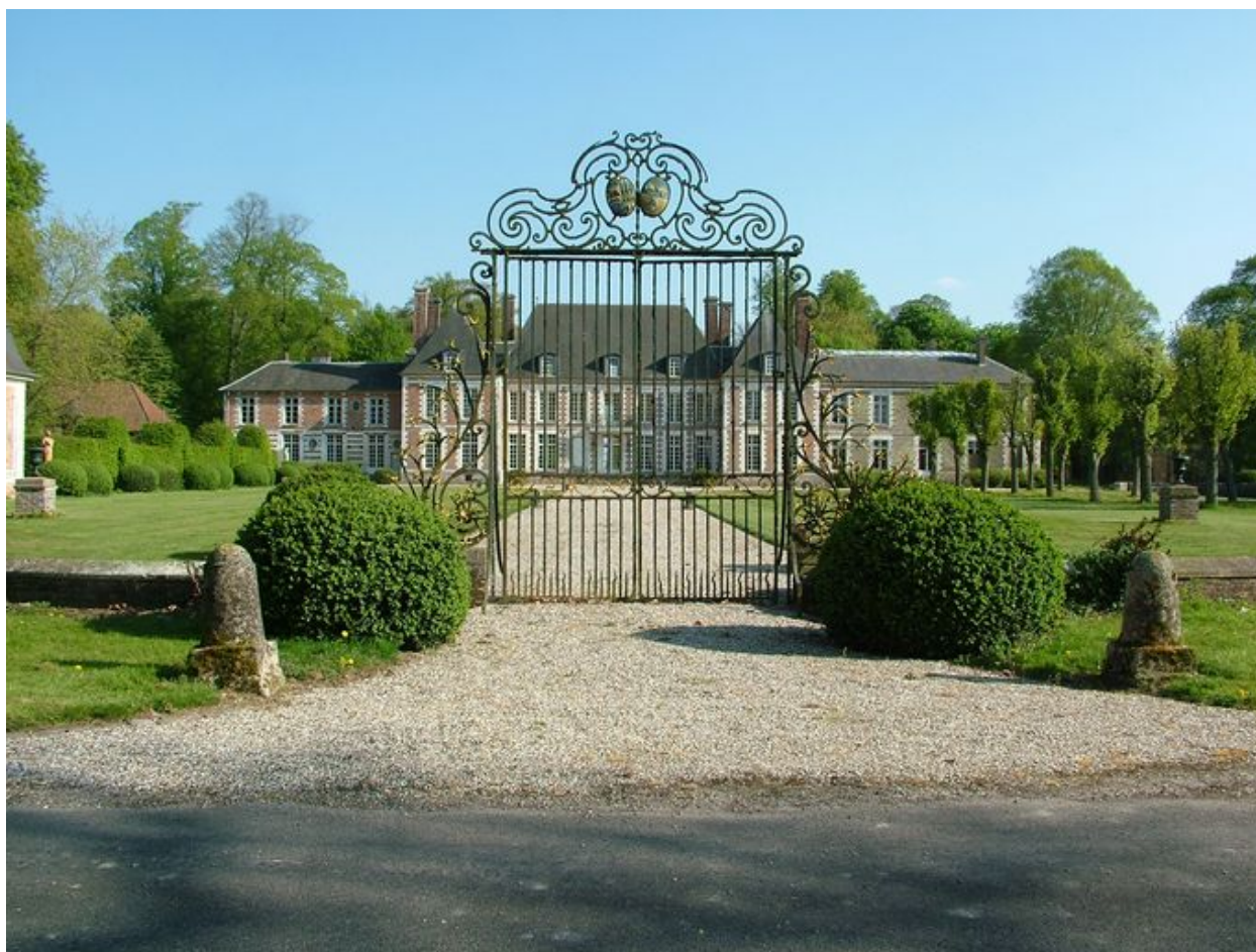
Grille principale, cour et logis.
