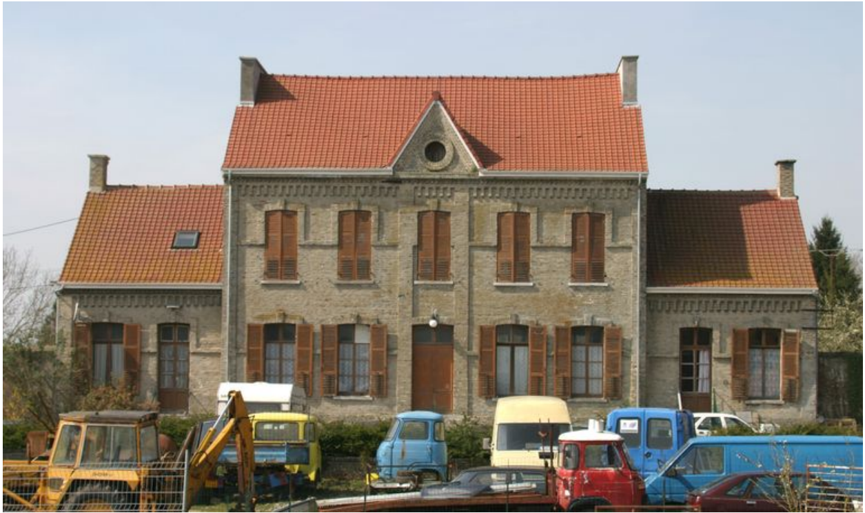
Vue du logis depuis l'est.
