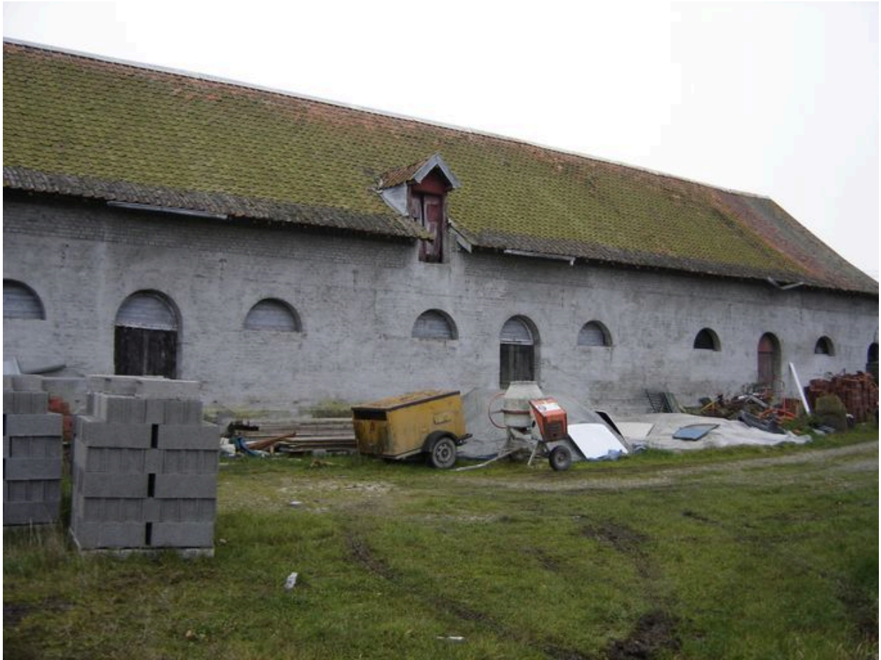
Vue sur l'étable depuis le sud-est.
