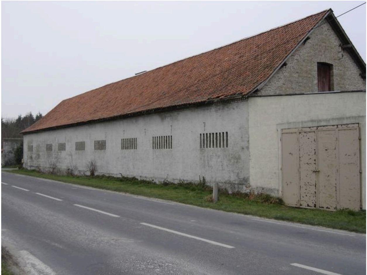
Vue sur la face sud de l'étable (avec ouvertures d'aération).
