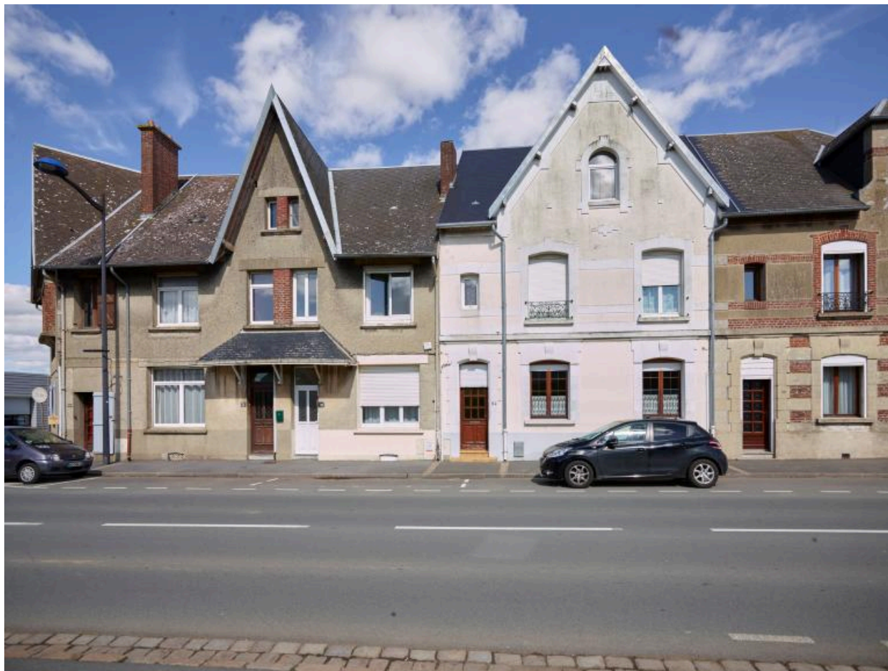
Vue sur la façade de la rue du faubourg de Péronne.
