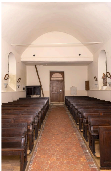
Vue intérieure de la nef. Phot. Marc Kérignard IVR32_20216000395NUCA
