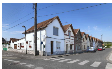
Logements ouvriers de la rue Nouvelle-Cité-Saint. Phot. Thierry Lefébure IVR22_20168000292NUC2AQ
