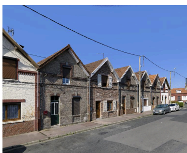
Logements ouvriers de la rue Henri-Piquet. Phot. Thierry Lefébure IVR22_20168000290NUC2A
