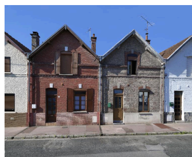
Logements ouvriers de la rue Henri- Piquet, façades des n° 18 et 20. Phot. Thierry Lefébure IVR22_20168000291NUC2A
