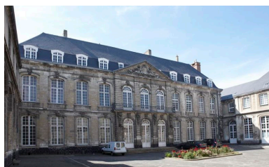
Vue générale. Phot. Pierre Thibaut IVR31_20086200143NUCA
