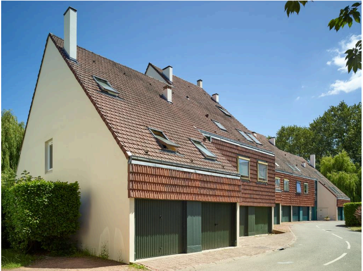
Vue depuis la voie de desserte. Façades antérieures des logements de la bande est du lotissement, avec garages et accès collectifs.
