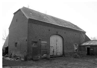
Grange, depuis la cour. Phot. Thierry Lefébure IVR22_19960200957X
