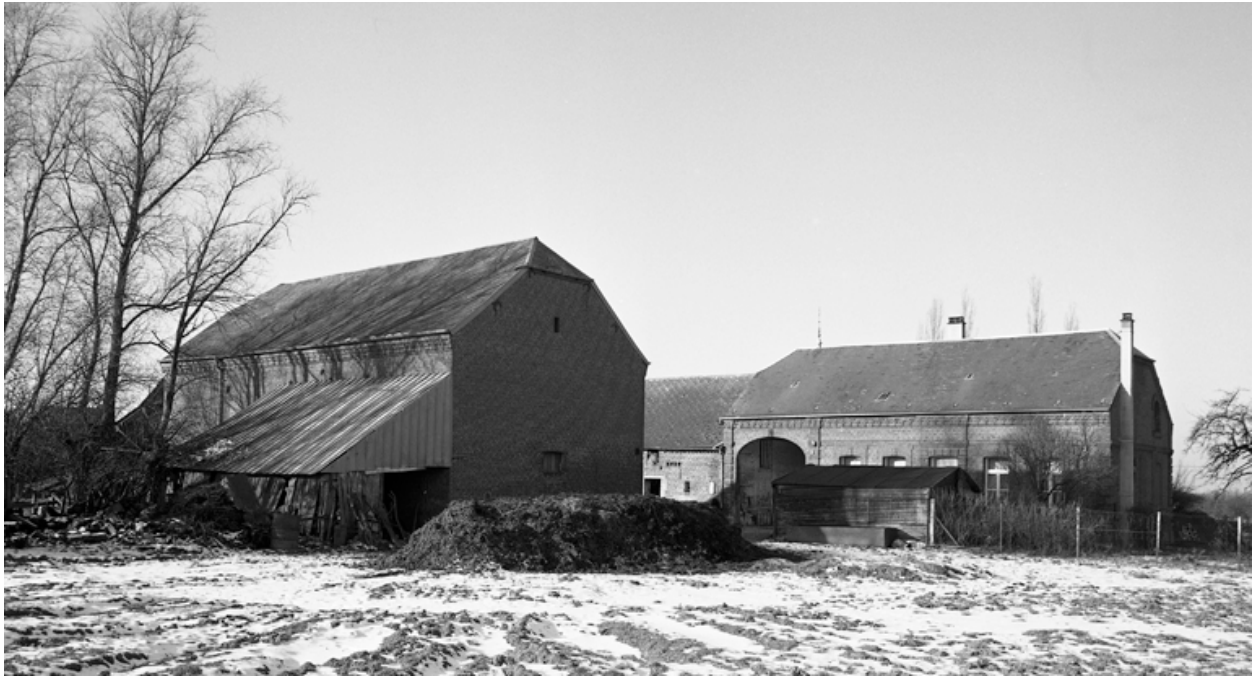
Vue générale, depuis l'est.
