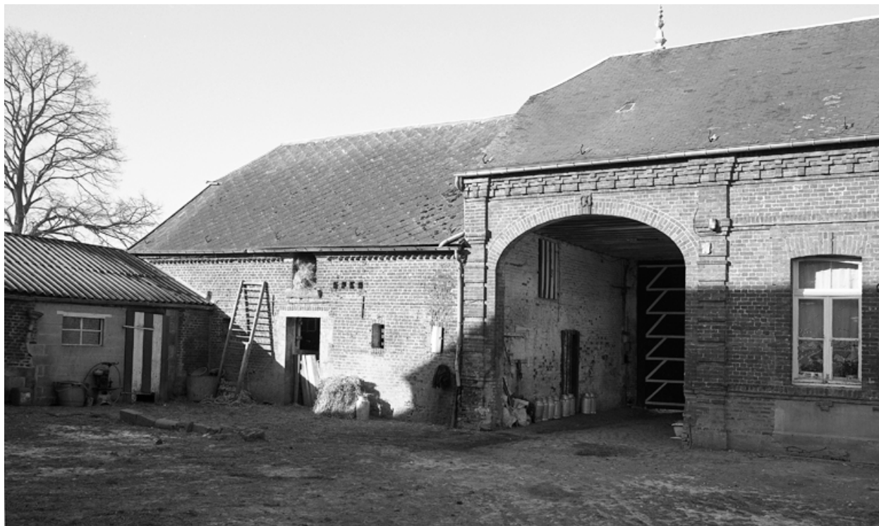
Elévation sur cour du logis et de l'étable voisine.
