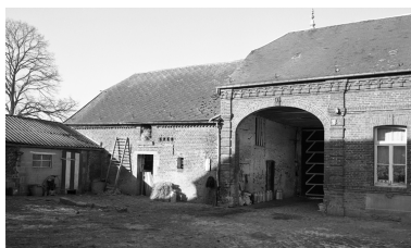
Elévation sur cour du logis et de l'étable voisine. Phot. Thierry Lefébure IVR22_19960200958X
