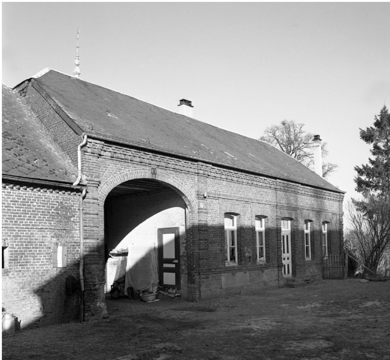
Elévation sur cour du logis et passage menant à l'extérieur.
