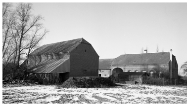
Vue générale, depuis l'est. Phot. Thierry Lefébure IVR22_19960200961X
