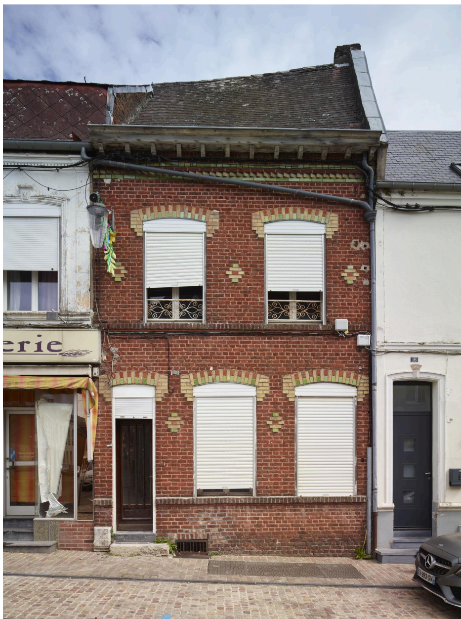
Maison - 18, rue du Maréchal-Joffre.
