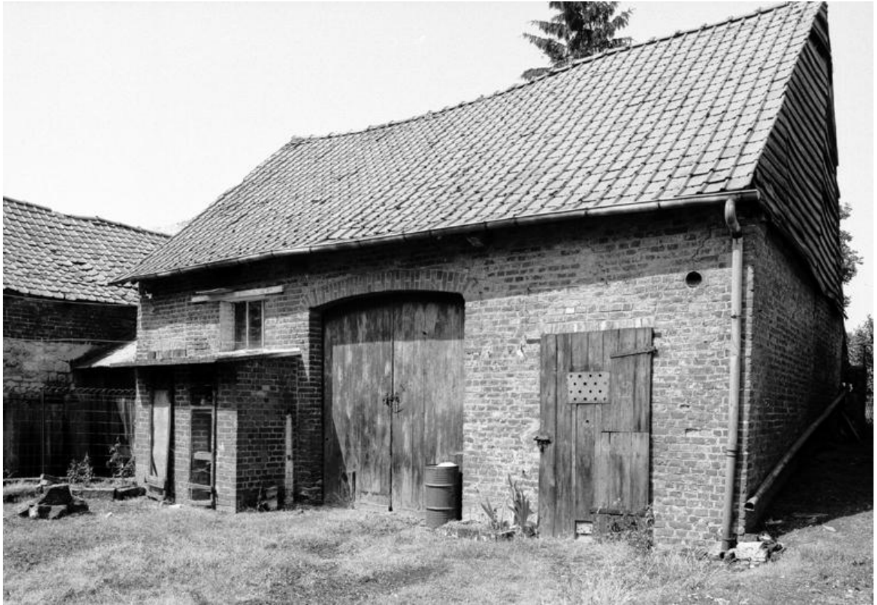
Vue de la remise, depuis le nord-est.
