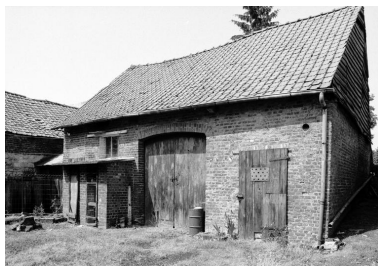
Vue de la remise, depuis le nord-est. Phot. Thierry Lefébure IVR22_19920201110Z
