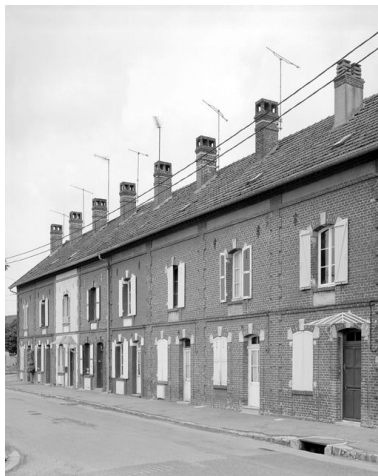
Elévation antérieure. Phot. Jean-Michel Perrin IVR22_19856000995V
