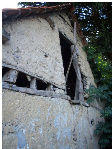
Vue du mur pignon en torchis avec gerbière. Phot. Inès Guérin IVR22_20068005111NUCA
