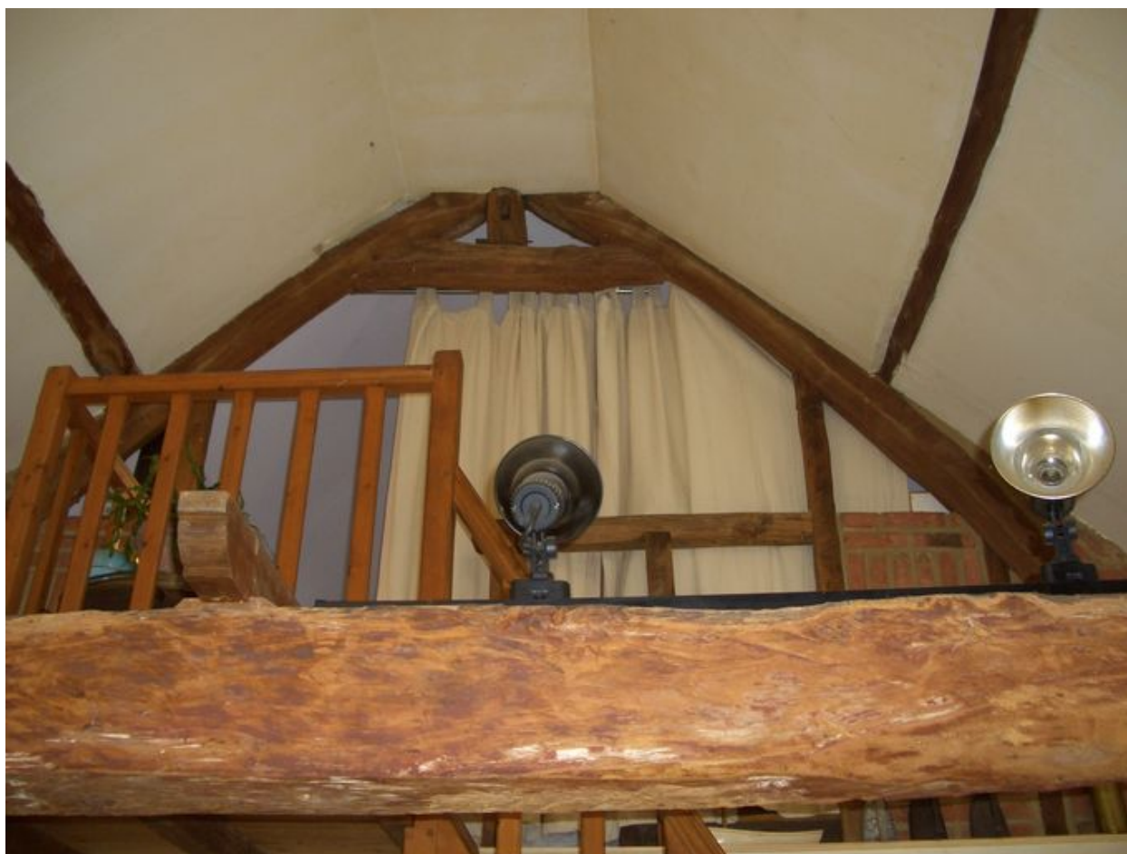
Vue d'une ferme de la charpente.
