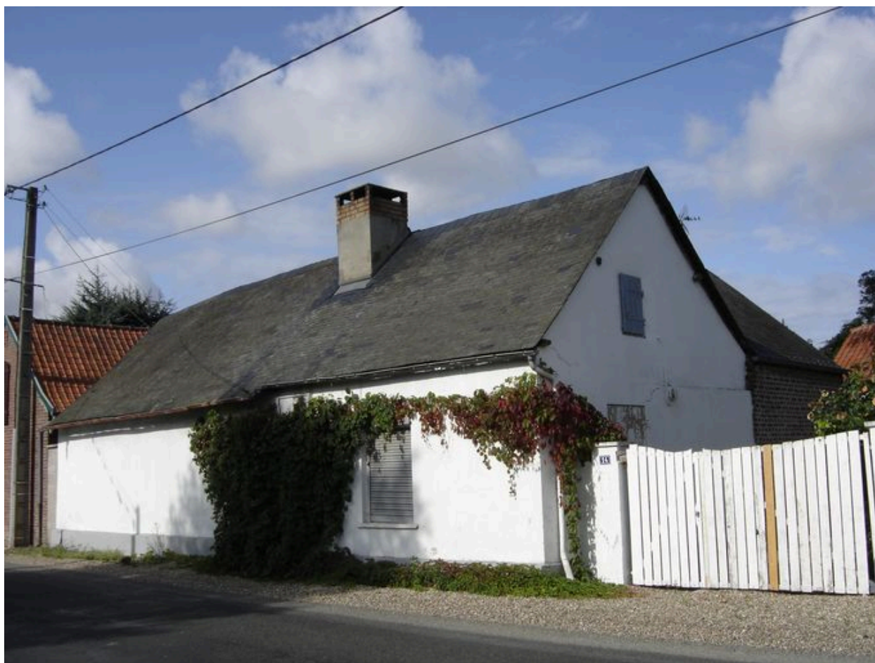
Vue du logis sur rue.
