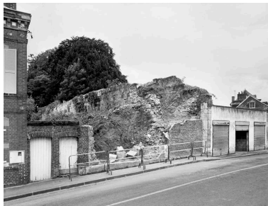
Vue réalisée en 1998, depuis la rue Condorcet, mettant en évidence la composition faite de 2 parements de grès et d'un remplissage de blocailles noyées dans un mortier.
