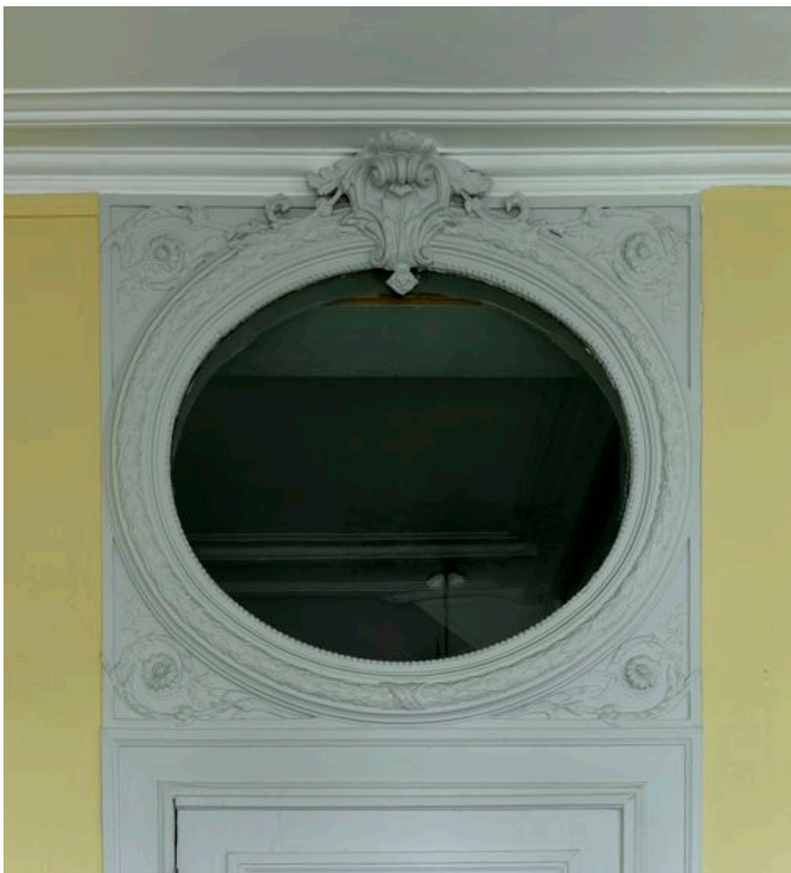
Imposte de l'antichambre (cabinet) du rez-de-chaussée.
