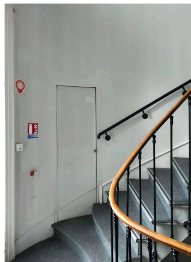
Porte des anciennes latrines accessibles depuis l'escalier principal. Phot. Thierry Lefébure IVR22_20128000804NUCA
