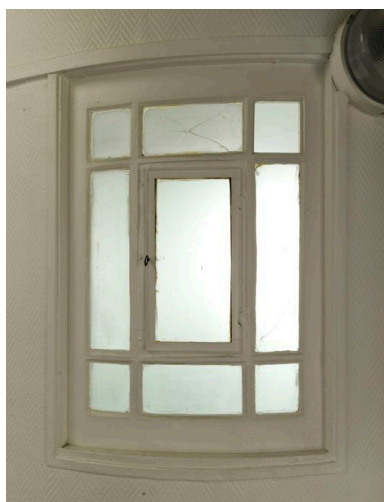
Regard sur la cage de l'escalier principal (deuxième étage). Phot. Thierry Lefébure IVR22_20128000806NUCA
