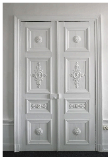
Porte de séparation entre la chambre (sur rue) et le cabinet du premier étage. Phot. Thierry Lefébure IVR22_20128000796NUCA
