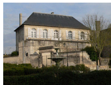
Vue d'un bâtiment subsistant de l'évêché. Phot. Christiane Riboulleau IVR22_20140205004NUCA
