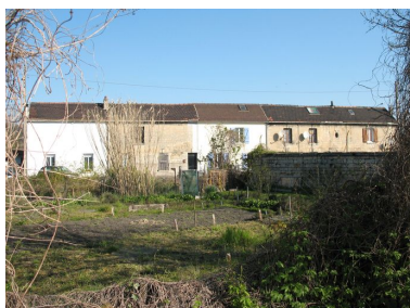
Vue rapprochée de la barre de logements. Phot. Clarisse Lorieux IVR22_20086005138NUCA
