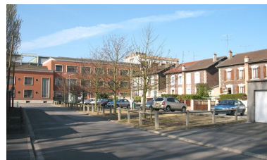
Bureaux de l'usine et cité Mertian. Phot. Clarisse Lorieux IVR22_20086005130NUCA
