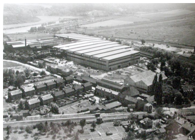
Vue aérienne de la société Usinor et de la cité Mertian, vers 1950 (archives d'entreprise). Phot. Clarisse Lorieux IVR22_20086005104NUCAB
