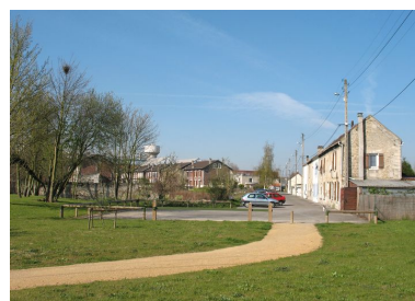
A droite : barre de 5 logements ouvriers en pierre, au centre le château d'eau de l'usine et à gauche un des barres de logements ouvriers en brique. Phot. Clarisse Lorieux IVR22_20086005135NUCA
