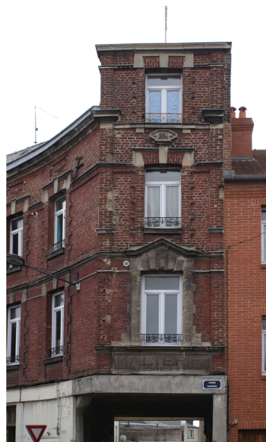
Façade antérieure des logements d'employés.
