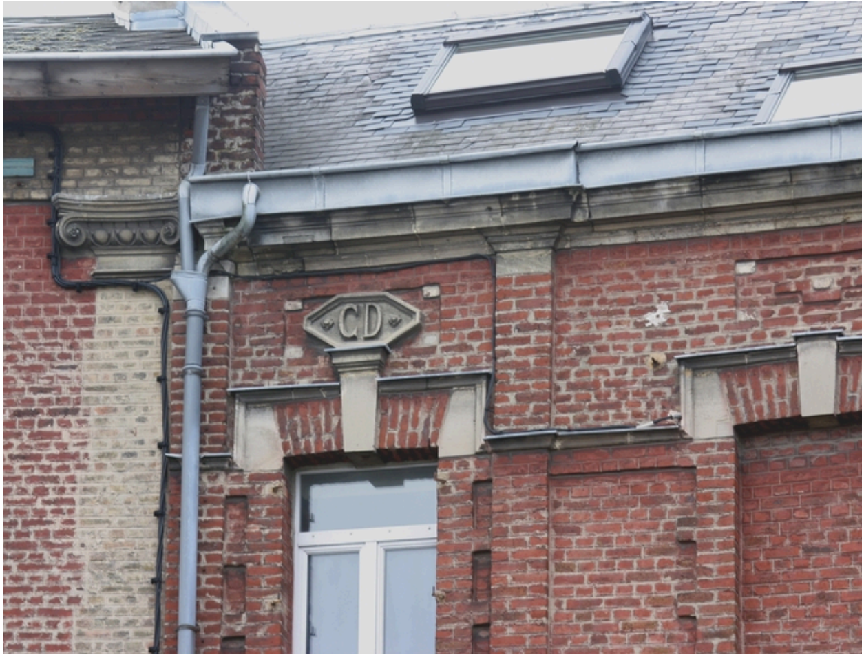
Façade antérieure des logements d'employés : détail.
