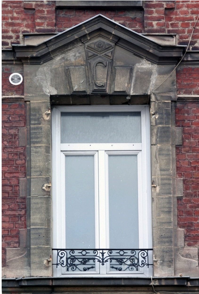
Baie de la façade antérieure des logements d'employés, surmontée du monogramme de Germain Cacheux.
