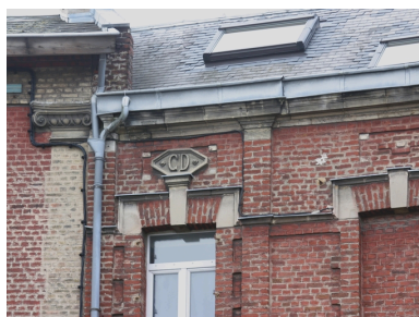
Façade antérieure des logements d'employés : détail.
