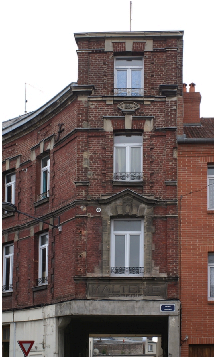
Façade antérieure des logements d'employés.
