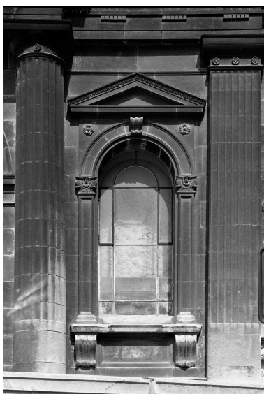
Palais de justice, façade sur place, baie : détail. Phot. Jean-Michel Périn, Phot. Éric Dessert IVR31_19806203002X
