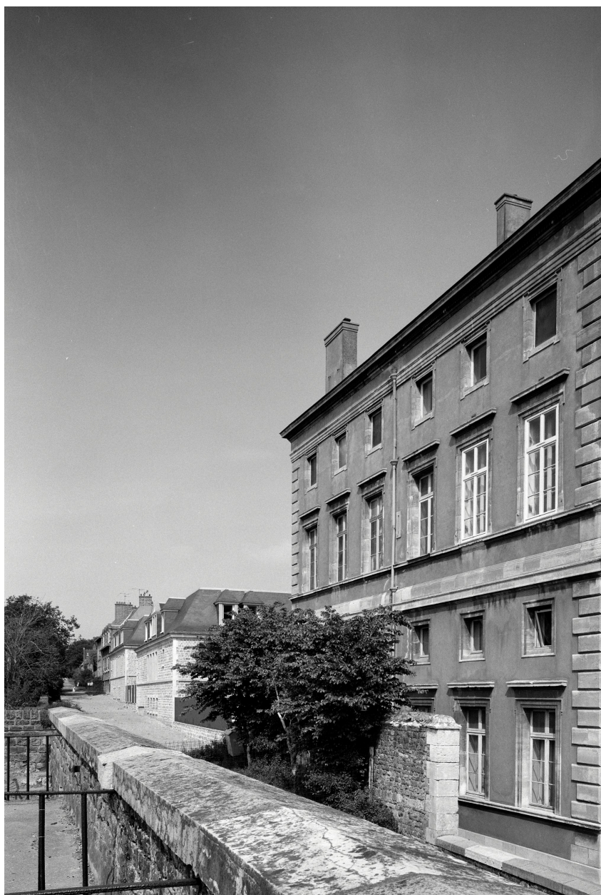
Palais de justice, façade sur les remparts.
