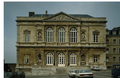
Façade sur place après restauration. Phot. Jean-Michel Périn IVR31_19876201441XA
