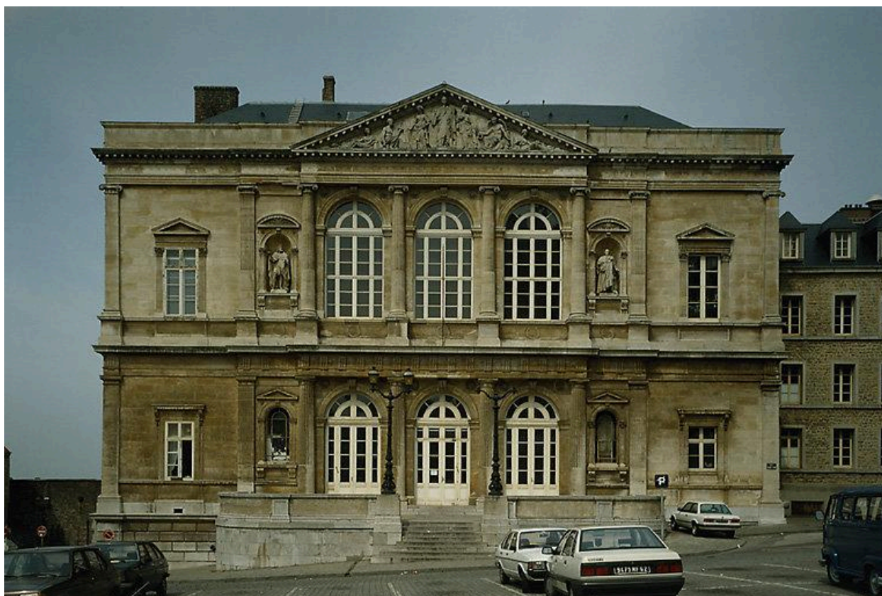
Façade sur place après restauration.
