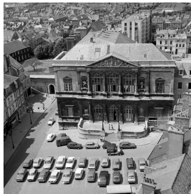
Palais de justice : vue aérienne du beffroi. Phot. Jean-Michel Périn IVR31_19806203056X
