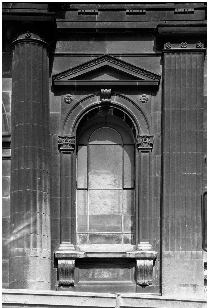
Palais de justice, façade sur place, baie : détail.
