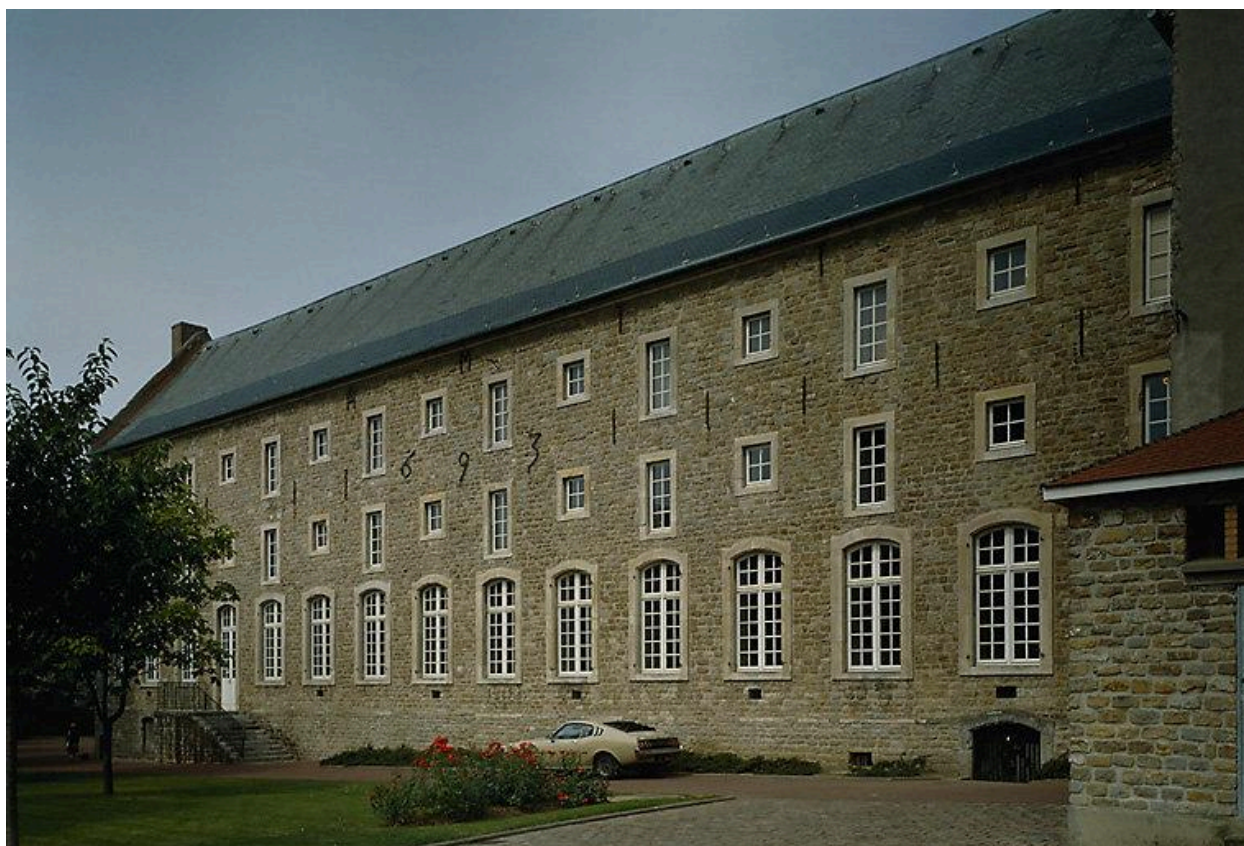
Façade sur jardin, vue générale.
