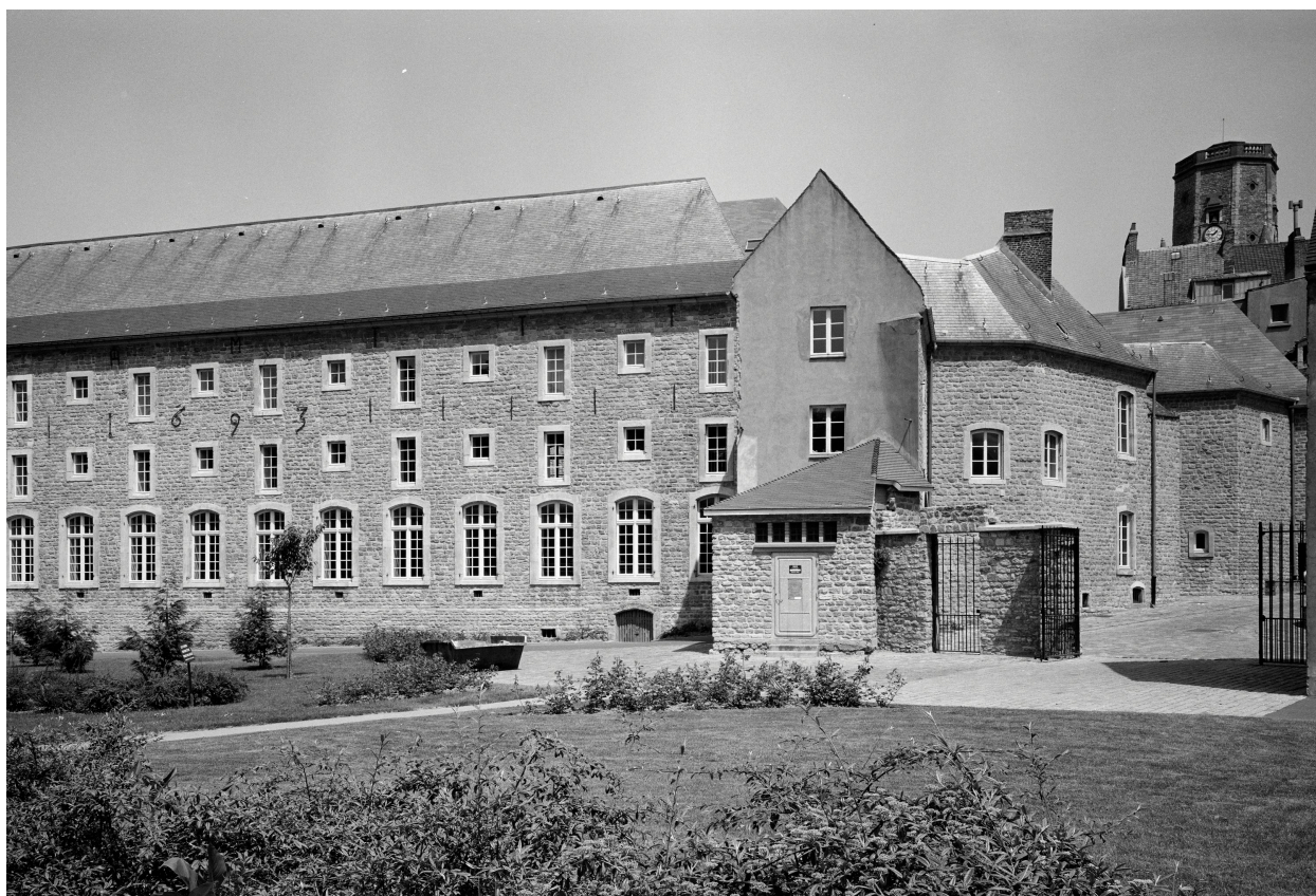
Vue d'ensemble des façades sur jardin et sur rue Guyale.
