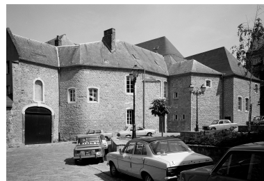
Façade rue Guyale. Phot. Éric Dessert, Phot. Jean-Michel Périn IVR31_19806202437X
