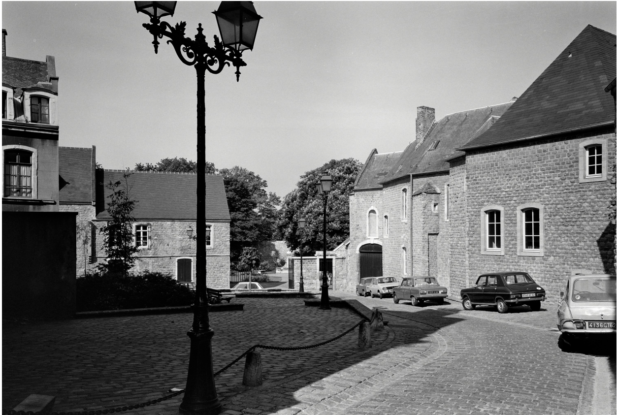
Vue générale sur la rue Guyale.
