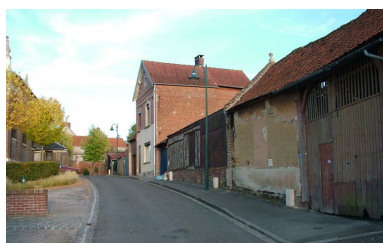
Rue de l'église. Phot. Frédéric Fournis IVR22_20098005436NUCA
