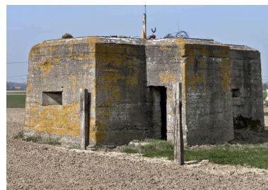
Vue vers le nord-ouest. L'entrée. Phot. Jean-Marc Ramette IVR31_20145904435NUCA
