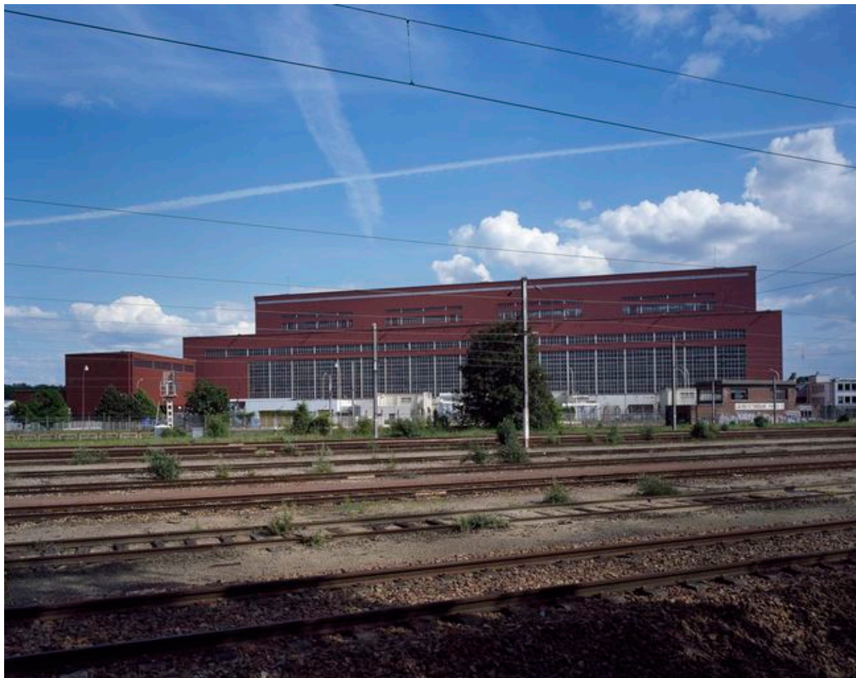
L'ancienne centrale depuis les voies ferrées.
