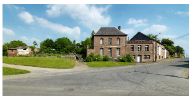
Vue d'ensemble sur rue. Phot. Thierry Lefébure IVR22_20138000225NUC2AQ
