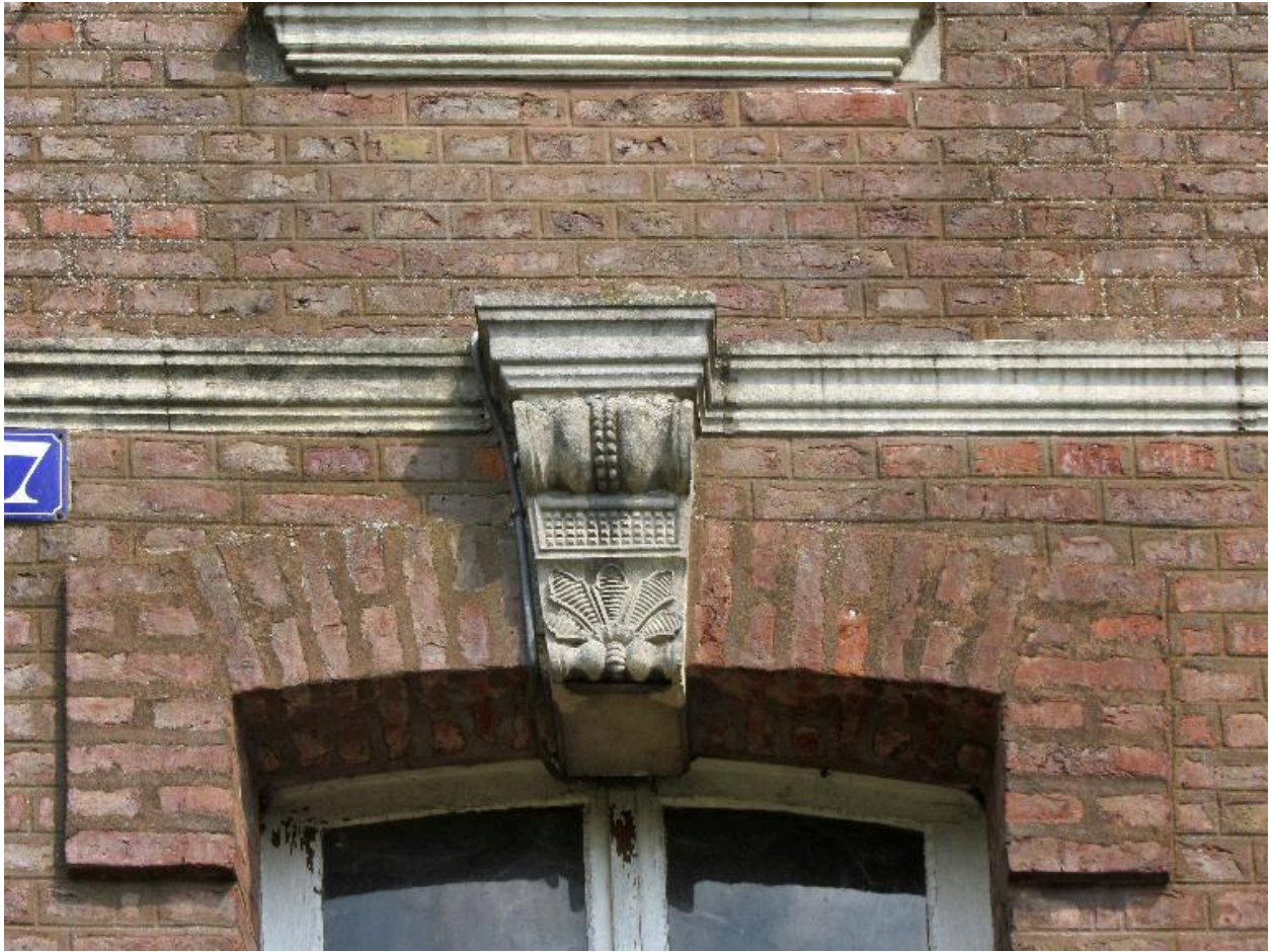
Détail du décor en agrafe du linteau de la porte d'entrée.
