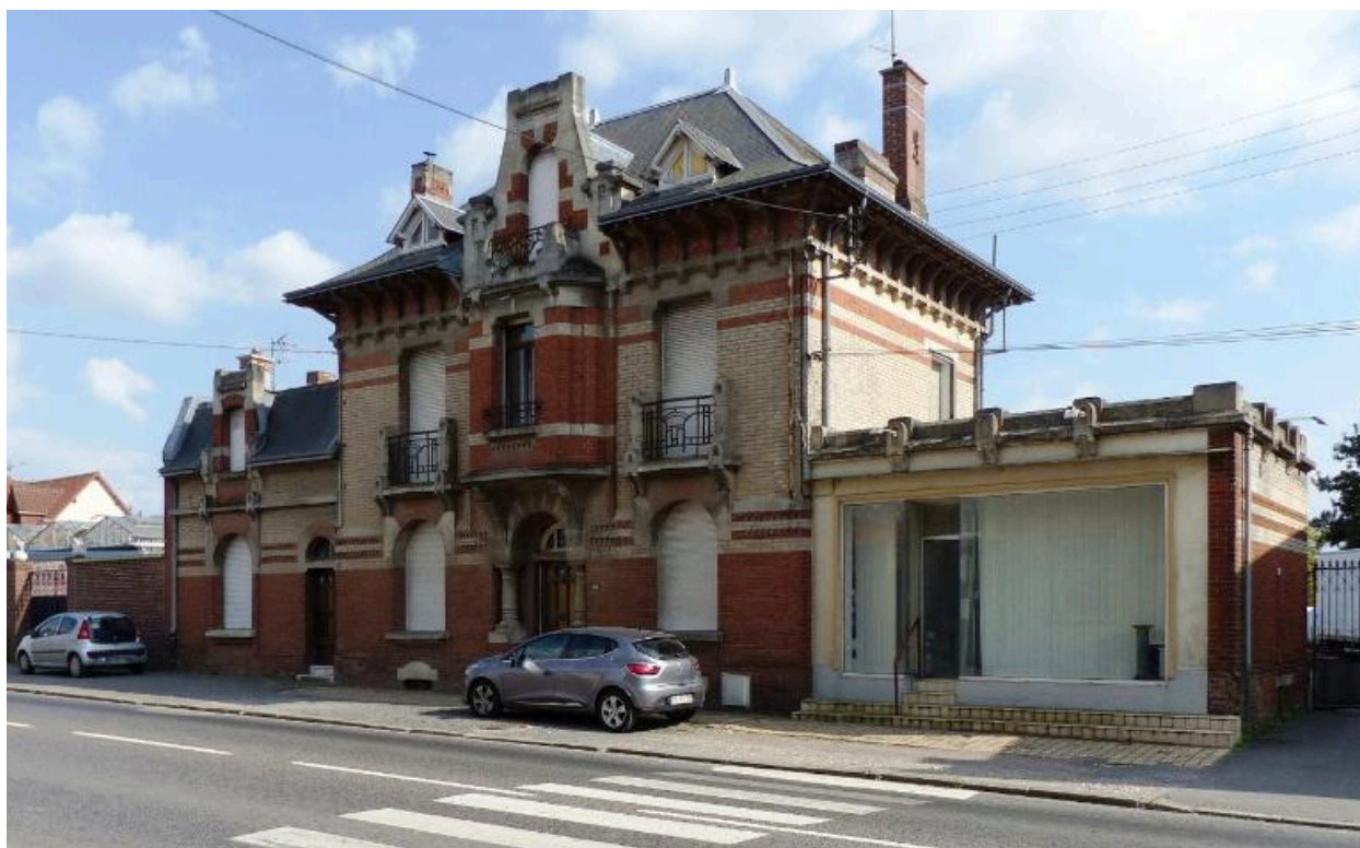
Ancienne maison du fabricant de bonneterie Jules Narcisse Lavallard.
