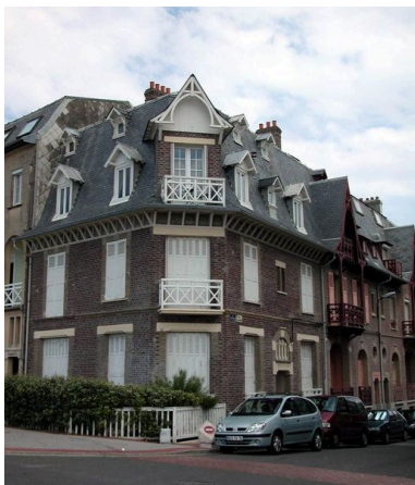
Vue d'ensemble depuis l'esplanade de la plage.
