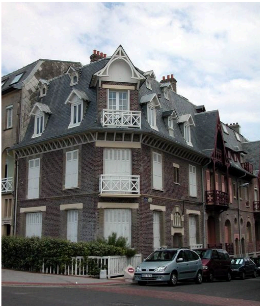
Vue d'ensemble depuis l'esplanade de la plage.
