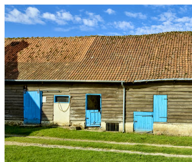
Détail des ouvertures de l'ancienne étable à cochons ou grange, depuis l'est. Phot. Thierry Lefébure IVR32_20248001113NUCA
