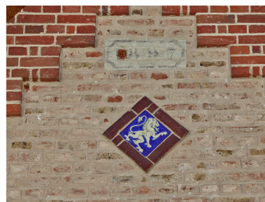
Date portée sur la grange au sud du manoir. Phot. Thierry Lefébure IVR32_20248001130NUCA
