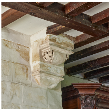
Détail d'un des corbeaux de la cheminée du manoir. Phot. Thierry Lefébure IVR32_20248001128NUCA
