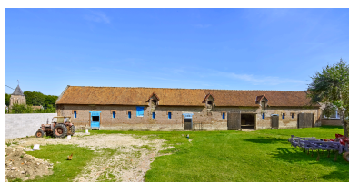
Vue des étables, depuis l'ouest. Phot. Thierry Lefébure IVR32_20248001124NUCA
