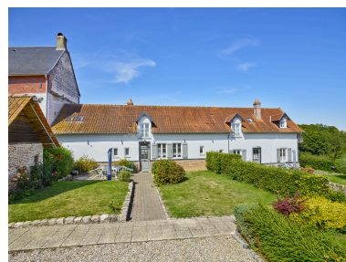
Vue des anciennes écuries, depuis le sud. Phot. Thierry Lefébure IVR32_20248001131NUCA
