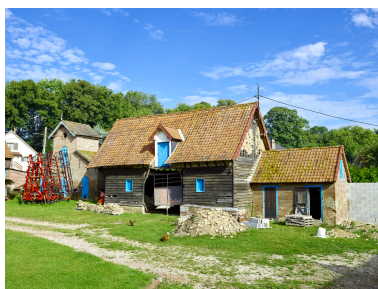
Vue de la bergerie, depuis le sud-est. Phot. Thierry Lefébure IVR32_20248001119NUCA
