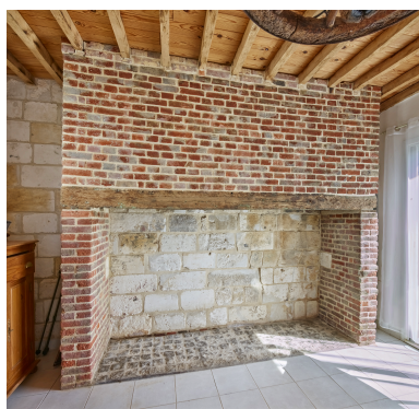
Cheminée du bâtiment au sud du manoir. Phot. Thierry Lefébure IVR32_20248001126NUCA
