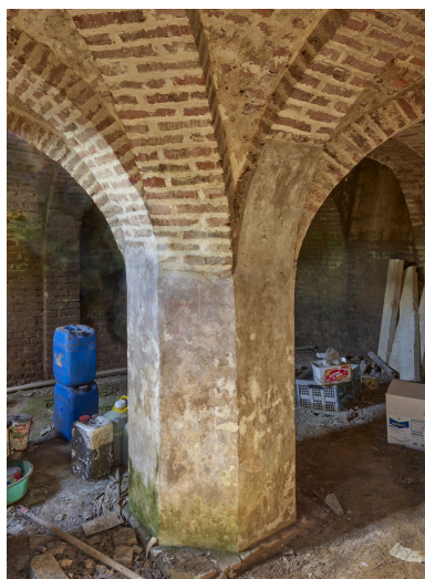
Cave sous l'étable. Phot. Thierry Lefébure IVR32_20248001115NUCA
