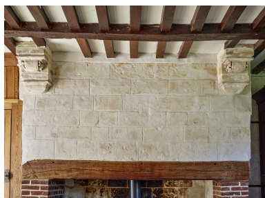
Détail de la hotte de la cheminée du manoir. Phot. Thierry Lefébure IVR32_20248001127NUCA
