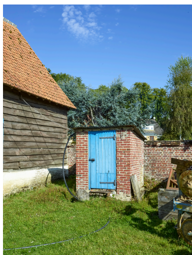
Vue du puits, depuis le sud. Phot. Thierry Lefébure IVR32_20248001121NUCA
