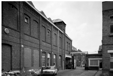
Entrée rue Béranger depuis la cour. Phot. Philippe Dapvril IVR31_19885901398X
