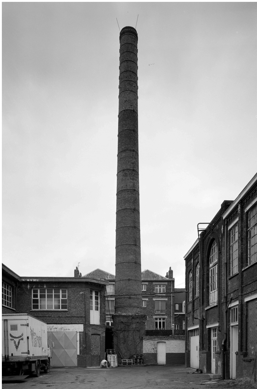
Cour vue depuis l'est. À droite, la salle des machines.
