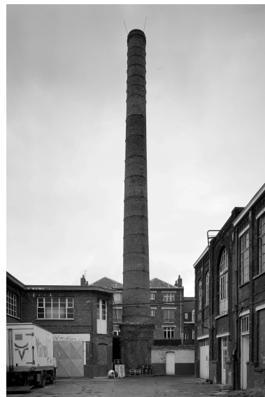
Cour vue depuis l'est. À droite, la salle des machines. Phot. Philippe Dapvril IVR31_19885901397X
