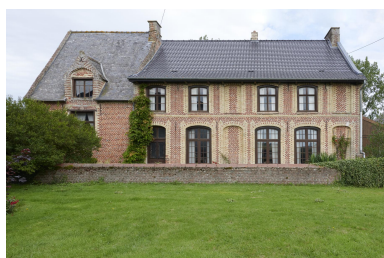
Façade sud-est du logis. Phot. Delphine Volto-Jourdan IVR32_20245902576NUCA
