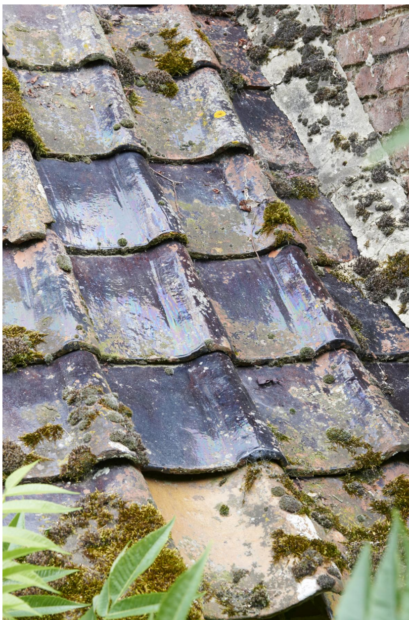
Annexe ouest du logis. Détail des tuiles en pannes flamandes vernissées.
