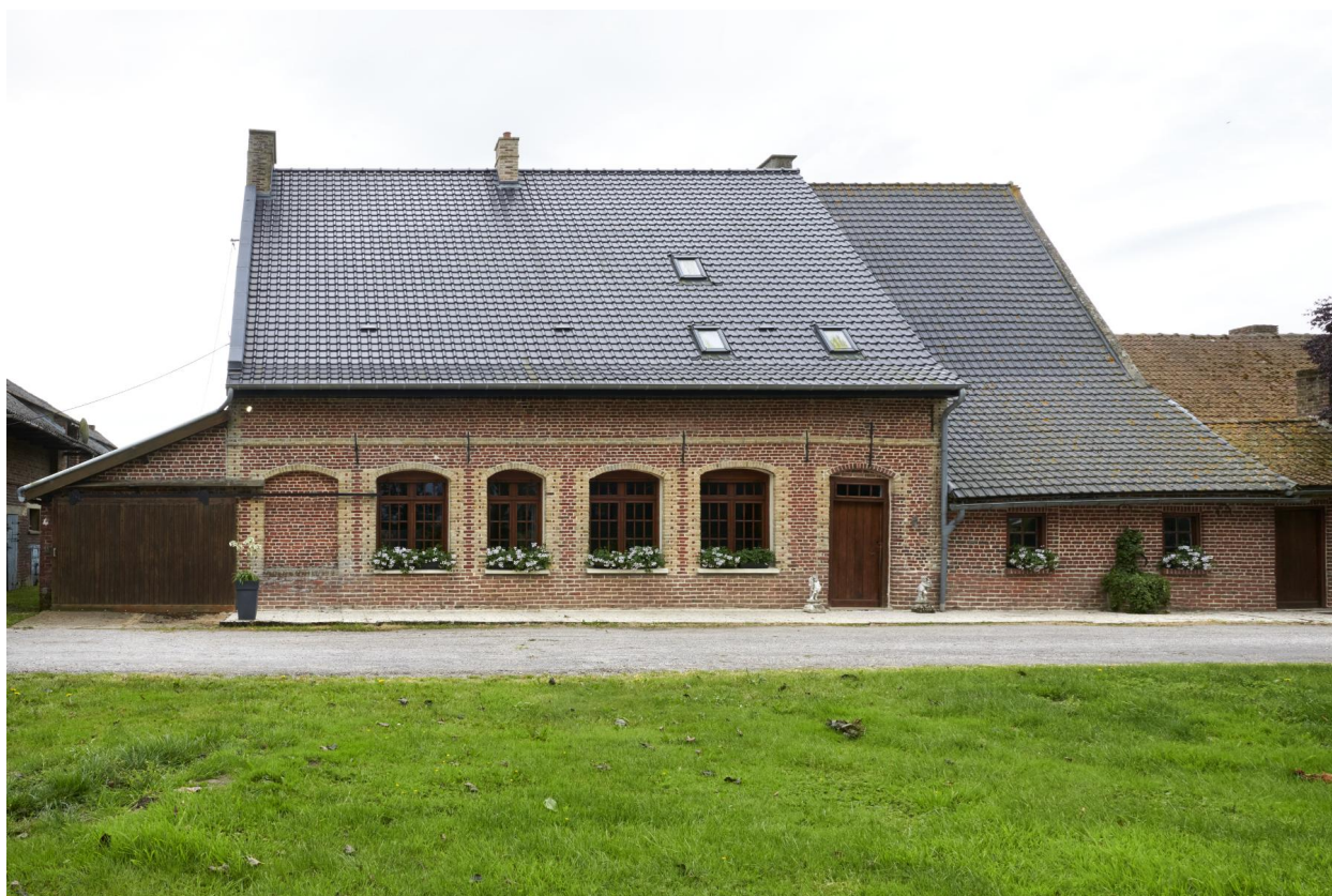
Logis, façade nord-ouest.
