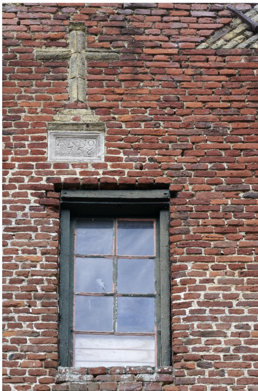
Détail du pignon nord-est, croix latine en brique jaune et date portée "ANNO 1758".
