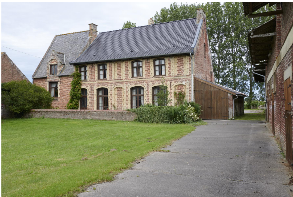
Façade sud-est du logis et pignon nord-est.
