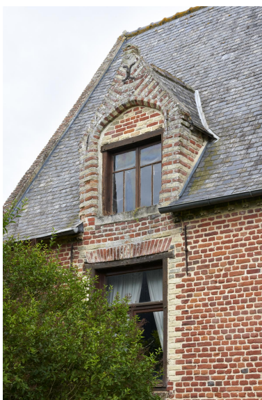
Détail d'une lucarne du logis. Phot. Delphine Volto-Jourdan IVR32_20245902577NUCA
