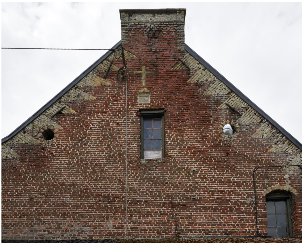
Haut du pignon nord-est, décor en brique jaune, baies, croix latine et date portée 'ANNO 1758'.
