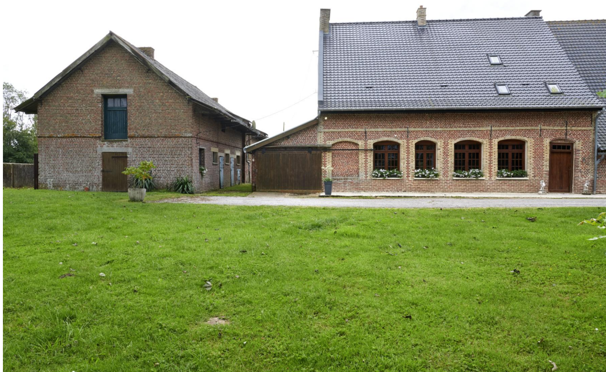
Façade nord-ouest du logis et pignon nord-ouest du bâtiment agricole.
