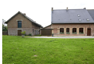
Façade nord-ouest du logis et pignon nord-ouest du bâtiment agricole. Phot. Delphine Volto-Jourdan IVR32_20245902581NUCA
