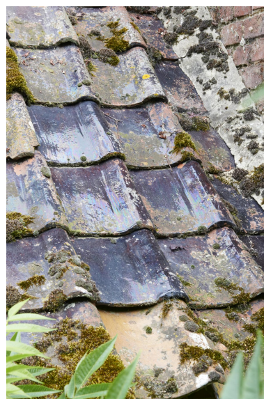
Annexe ouest du logis. Détail des tuiles en pannes flamandes vernissées. Phot. Delphine Volto-Jourdan IVR32_20245902584NUCA
