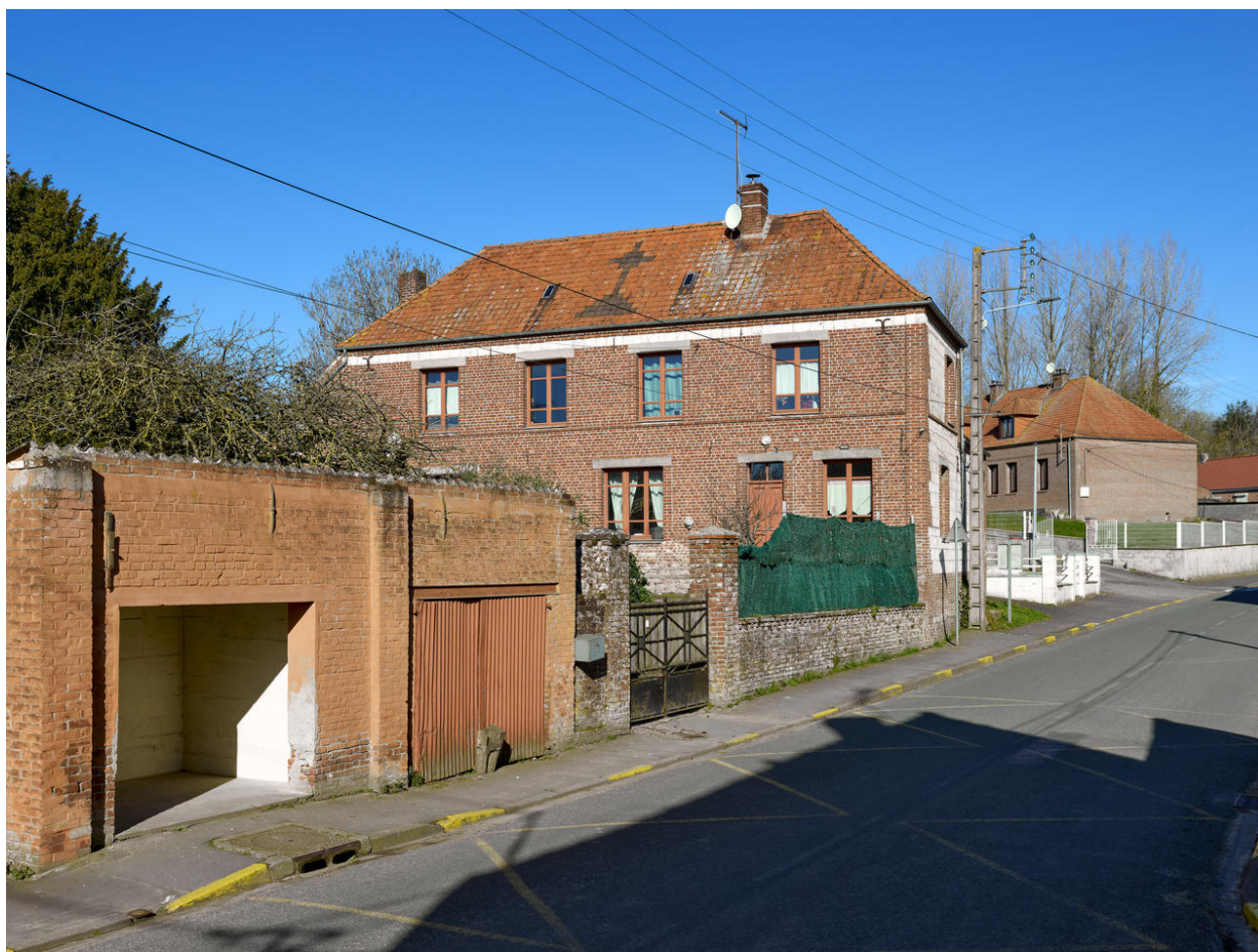
Vue de l'élévation sud.
