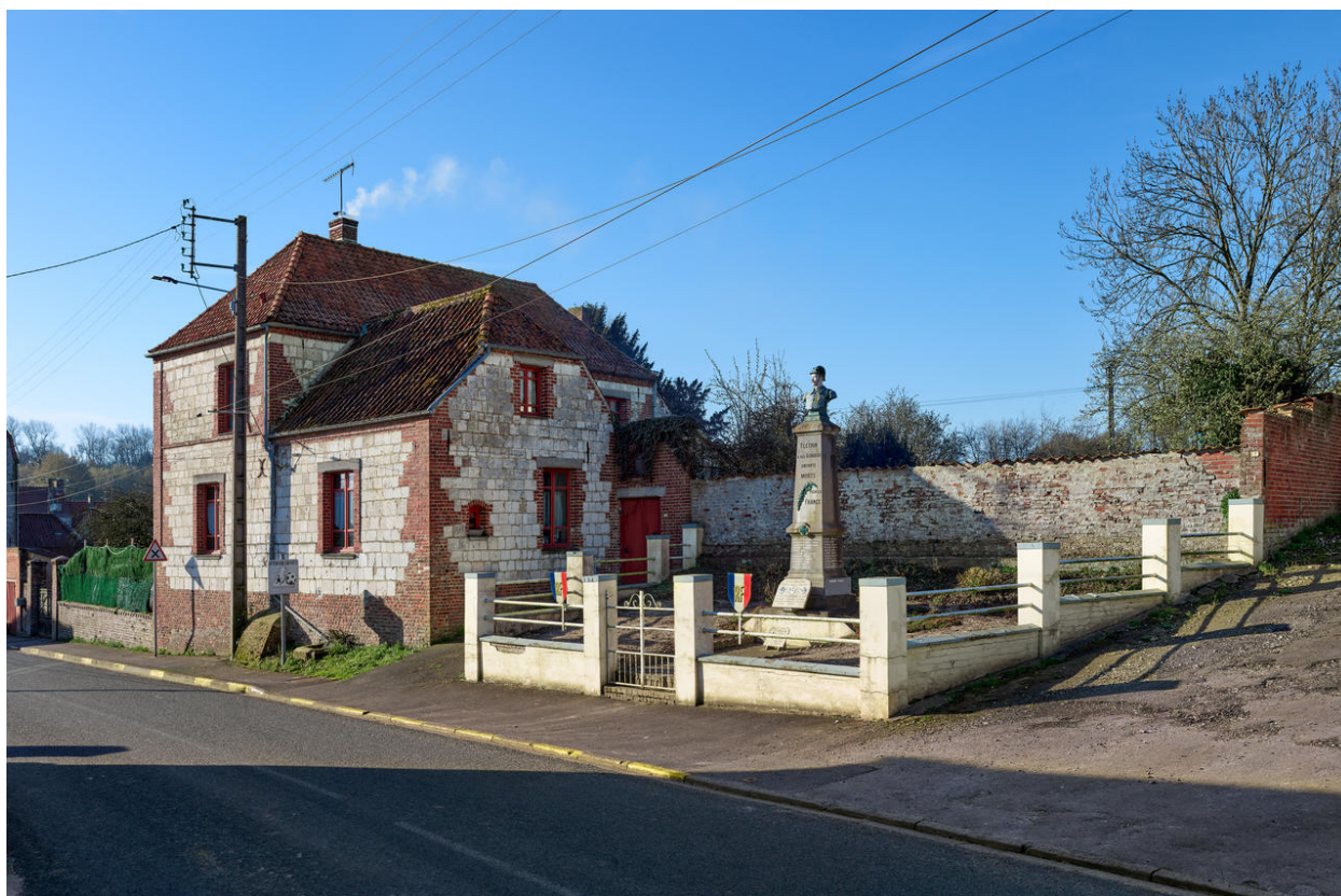
Vue de l'élévation nord.
