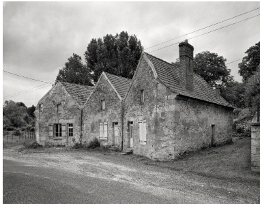
Vue générale des trois maisons, depuis le sud-ouest. Phot. Thierry Lefébure IVR22_19900201123V
