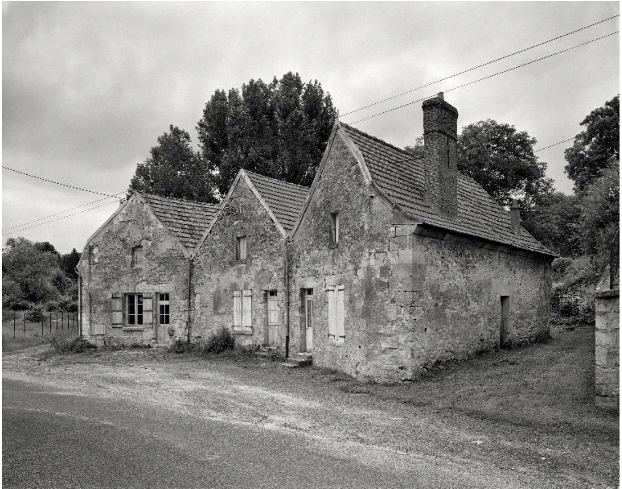
Vue générale des trois maisons, depuis le sud-ouest.
