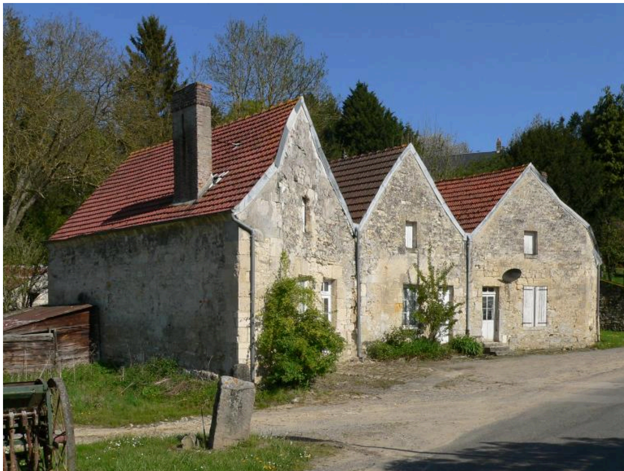
Vue générale, depuis le nord-ouest.
