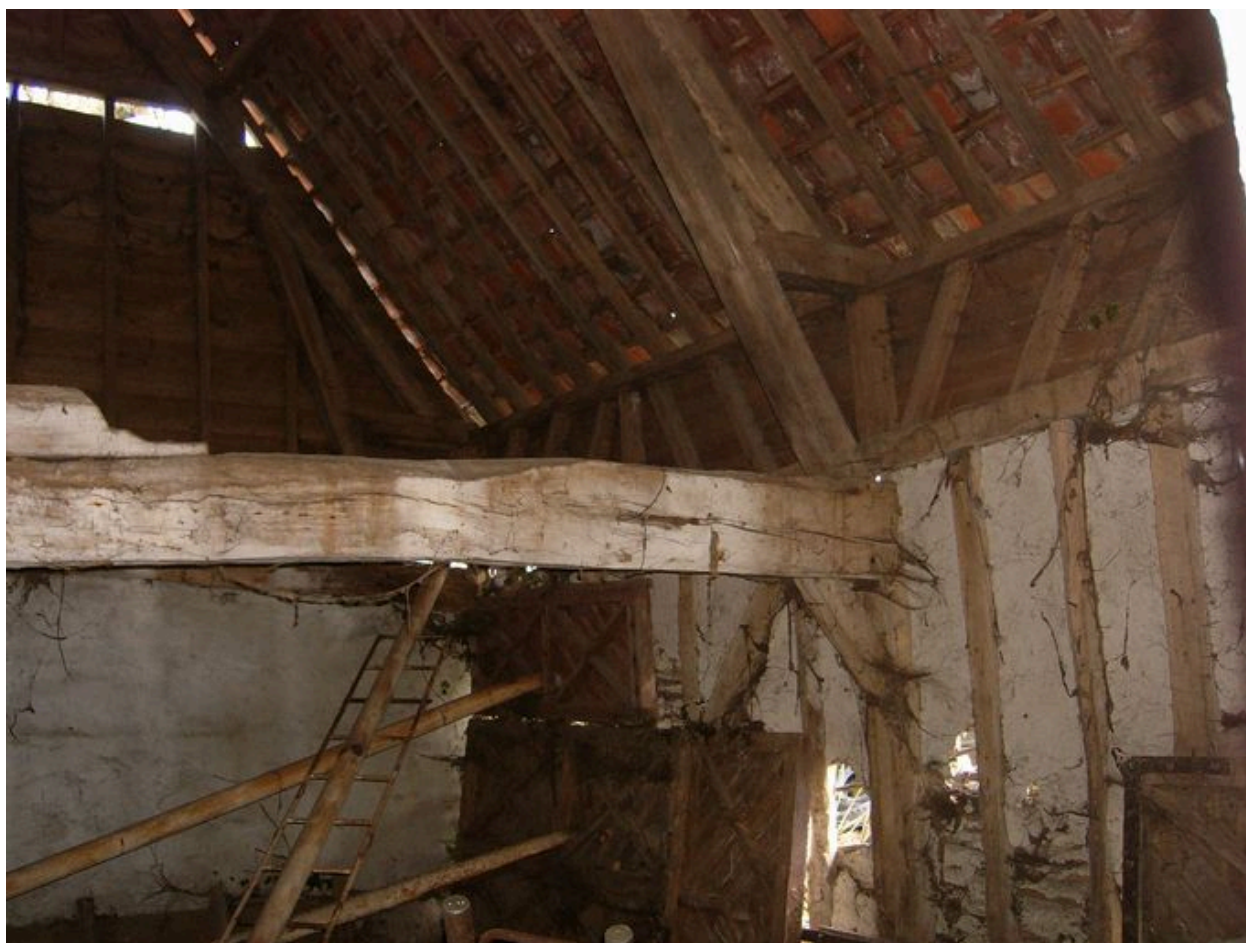
Vue intérieure de la grange.
