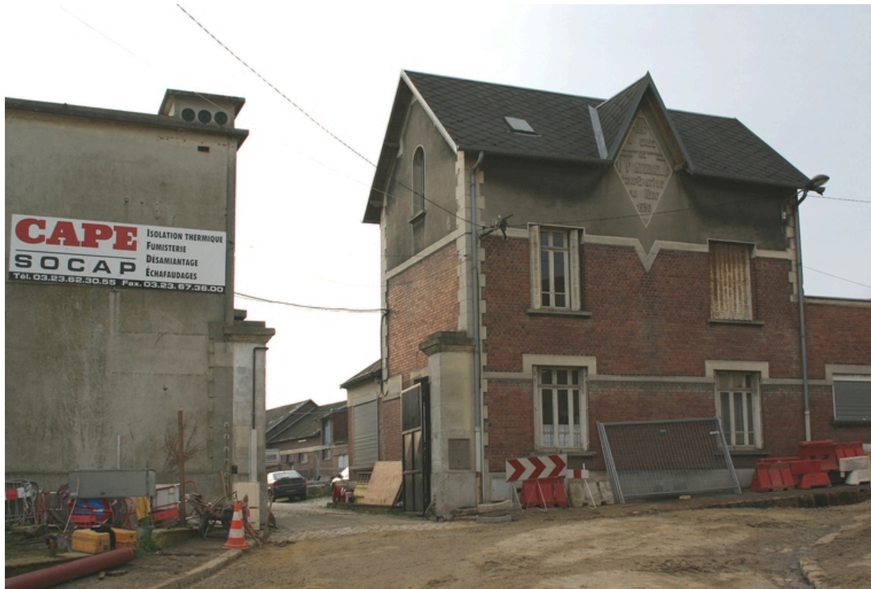
Entrée du site et bureau.
