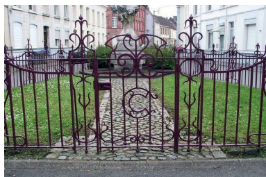
Grille de clôture, détail : porte à un battant portant le C initial de Clairon.
