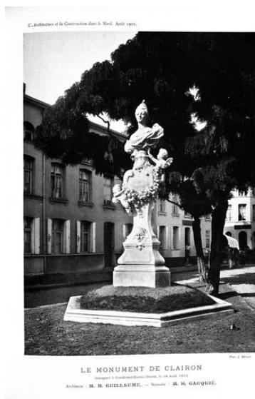
Vue générale du monument, photographie, par J. Delsart, 1901. In : L'Architecture et la construction dans le Nord. Repro. Pierre Thibaut, Autr. J. Delsart IVR31_20045900172X
