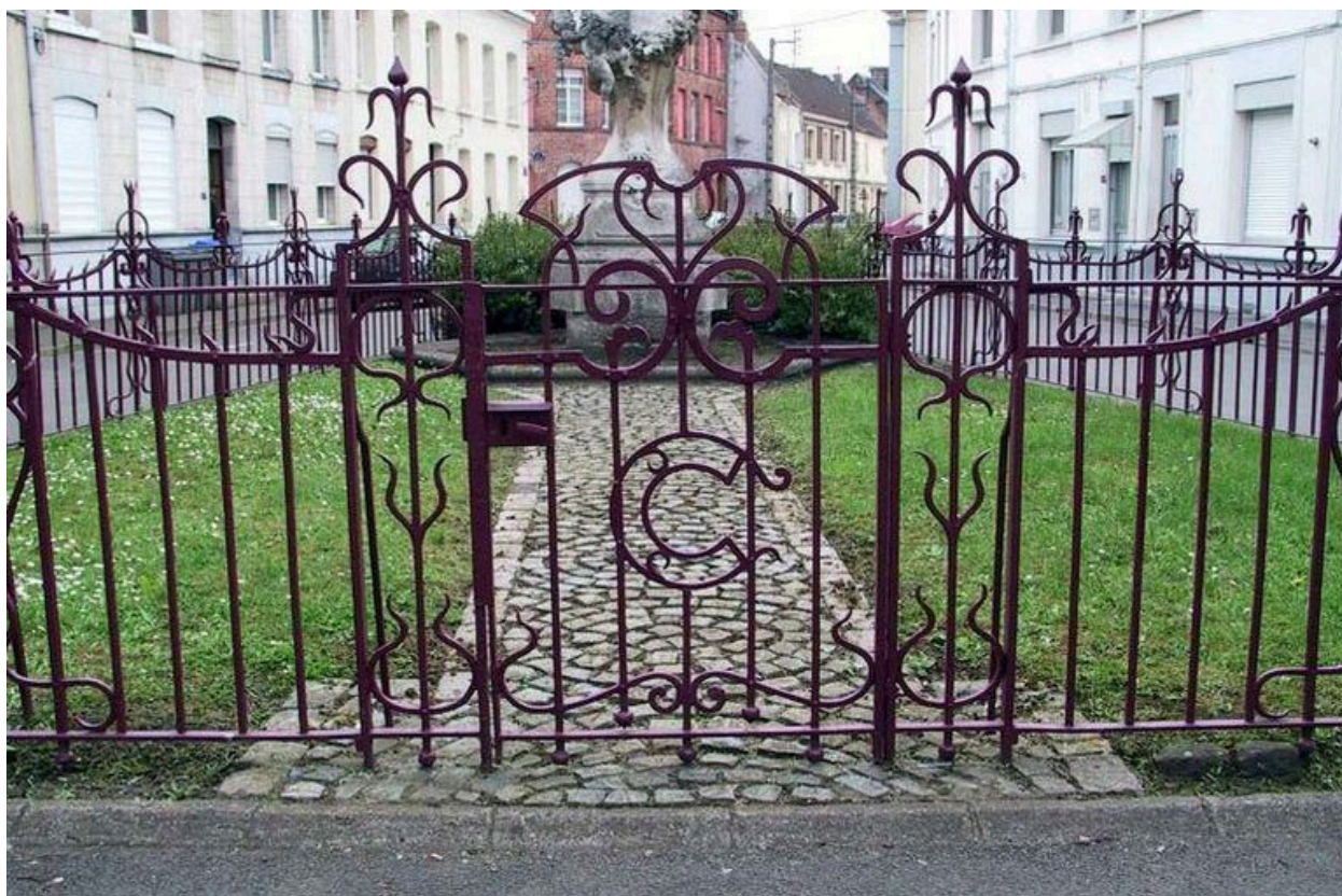
Grille de clôture, détail : porte à un battant portant le C initial de Clairon.
