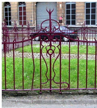
Grille de clôture, détail : un montant flanqué de panneaux, avec motifs en coups de fouet.
