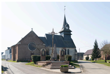
Vue générale de l'élévation nord. Phot. Lucile Chamignon IVR32_20226000167NUCA
