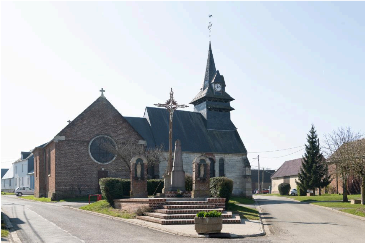
Vue générale de l'élévation nord.
