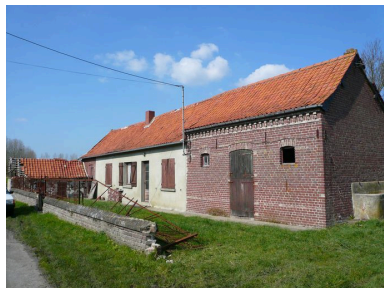
Vue générale. Phot. Inès Guérin IVR22_20078005512NUCA
