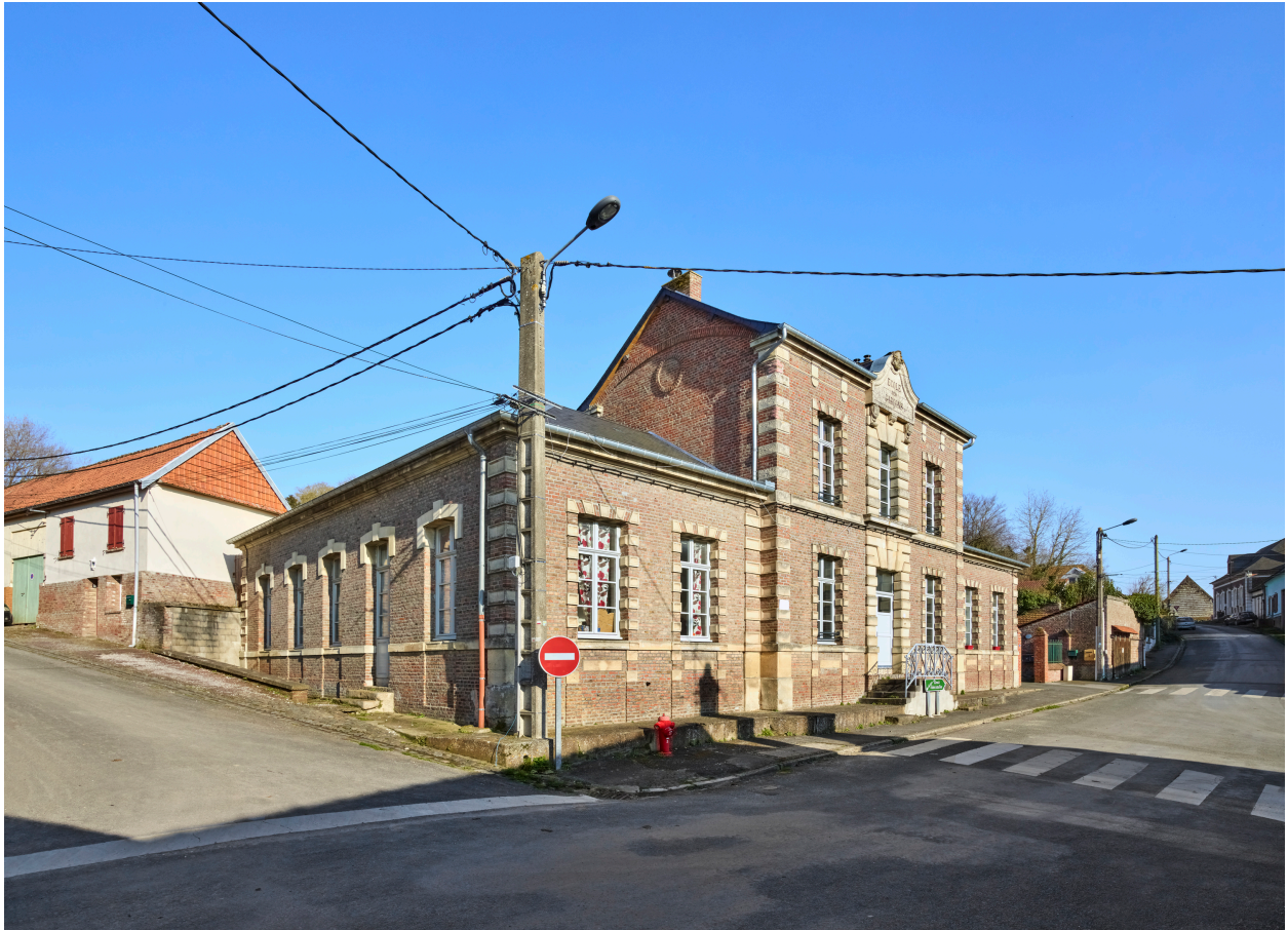
Vue de l'ancienne école des garçons, depuis l'ouest.
