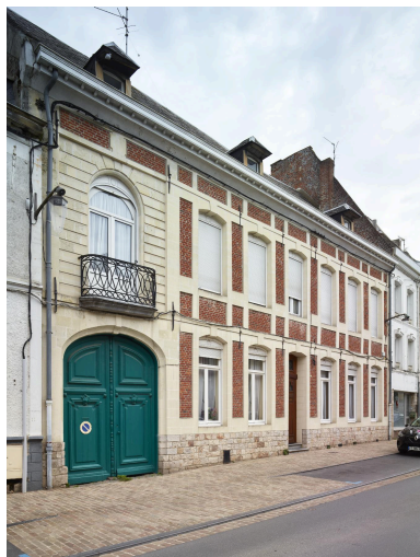
Façade principale sur la rue Thiers. Vue orientée nord/sud. Phot. Pierre Thibaut IVR32_20245900045NUCA
