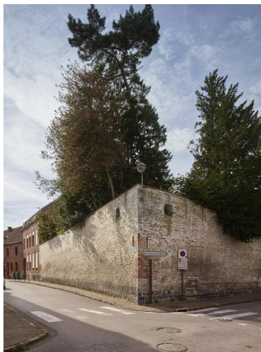
Mur clôturant le jardin associé à la maison n°20, rue Thiers - angles rues Jean-Jaurès et de l'Aulette. Phot. Pierre Thibaut IVR32_20245900849NUCA
