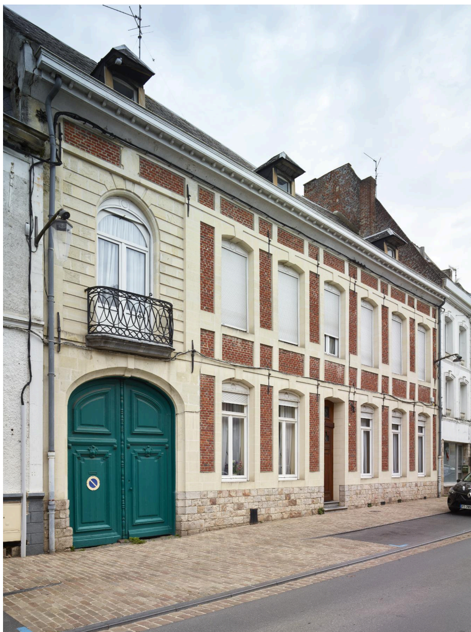
Façade principale sur la rue Thiers. Vue orientée nord/sud.
