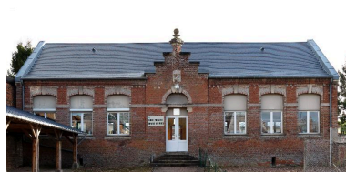
Vue du bâtiment des classes. Phot. Marie-Laure Monnehay-Vulliet IVR22_20148000099NUC2A
