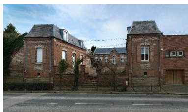
Vue générale. Phot. Marie-Laure Monnehay-Vulliet IVR22_20148000102NUC2AQ
