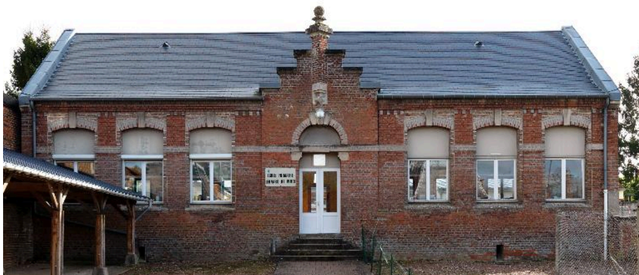
Vue du bâtiment des classes.
