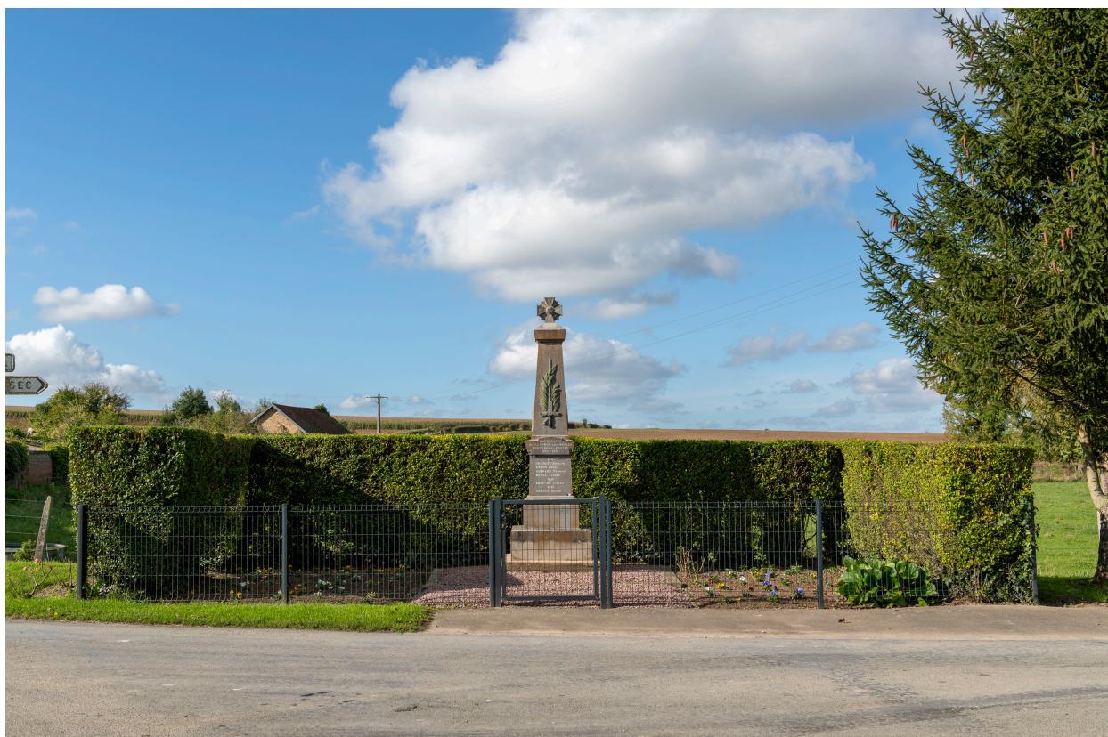
Monument aux morts, vue depuis l'est.
