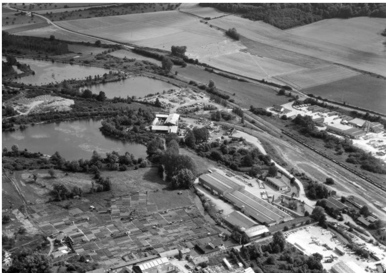
Vue aérienne, flanc ouest.
