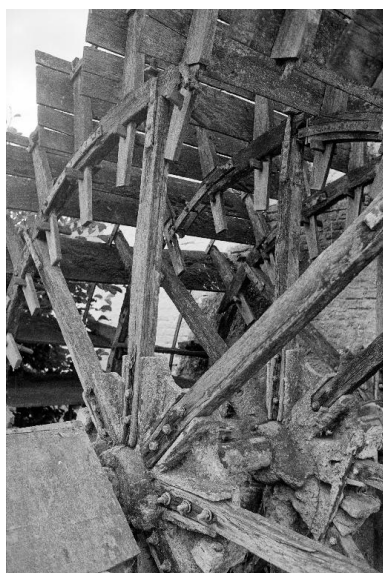
Roue hydraulique. Phot. Francis Dubuc IVR22_19908000625Z
