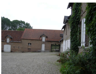
Vue de la cidrerie flanquée du corps de passage donnant accès à la pâture. Phot. Inès Guérin IVR22_20058006183NUCA
