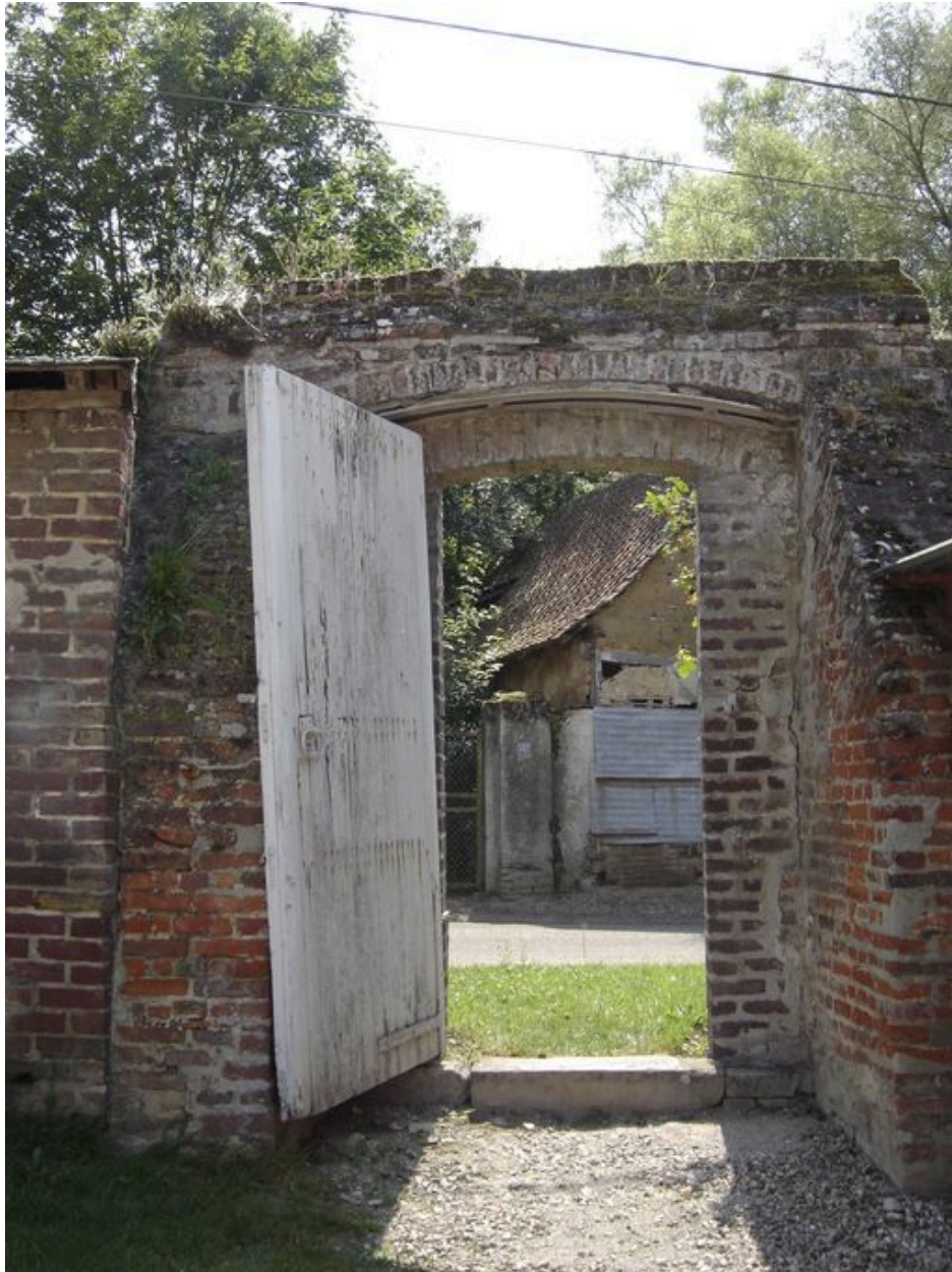
Porte piétonne donnant accès à la grande cour.
