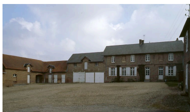
Vue du logis et des bâtiments accolés. Phot. Irwin Leullier IVR22_20078000058XA
