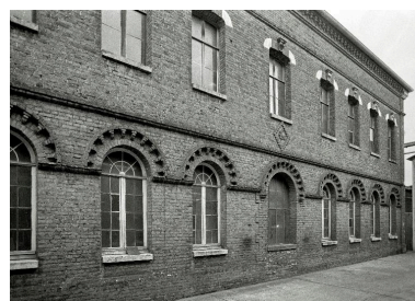
Détail de l'élévation antérieure de l'atelier de fabrication, en 1990. Phot. Francis Dubuc IVR22_19908000149Z
