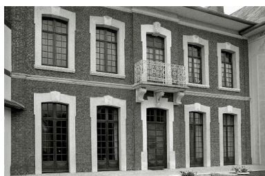
Elévation antérieure, en 1990. Phot. Francis Dubuc IVR22_19908000164Z
