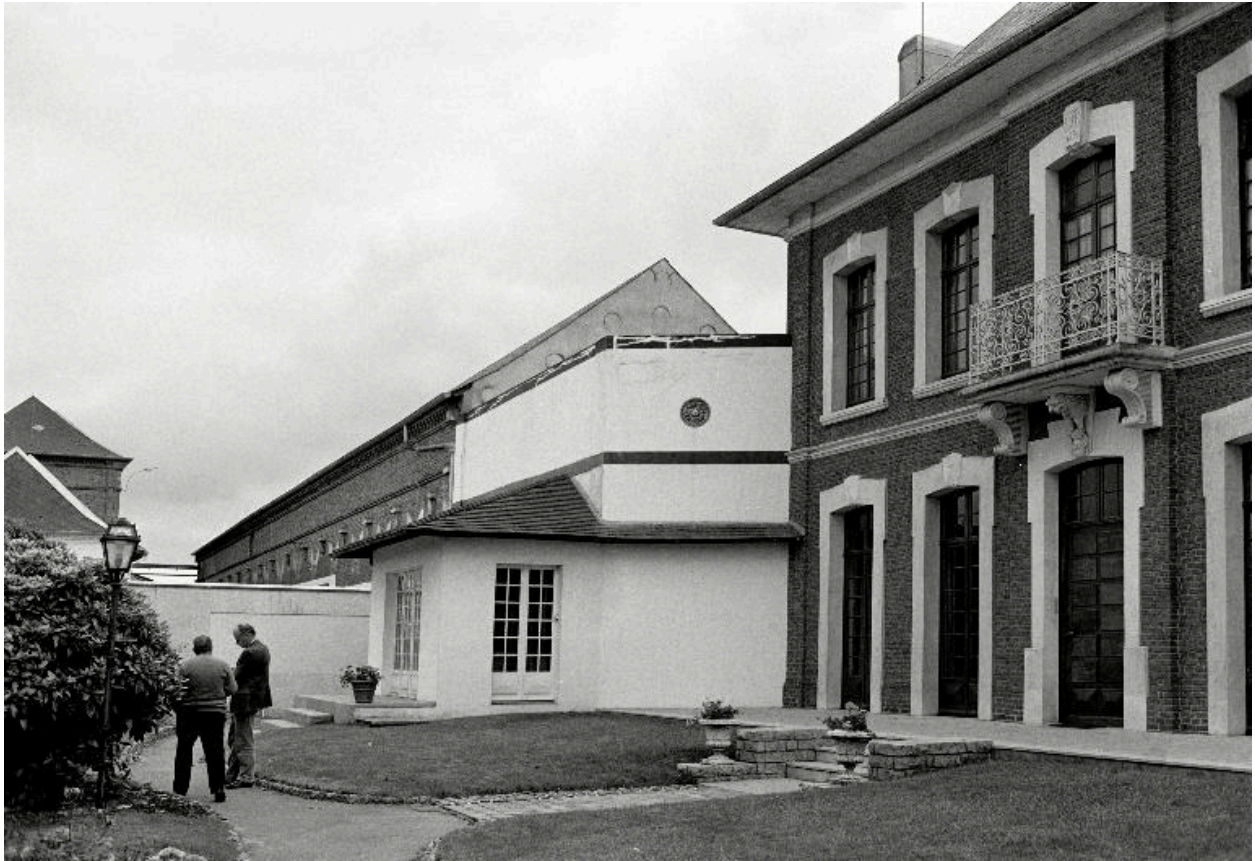
Le logement patronal, 3 rue Gambetta, en 1990.
