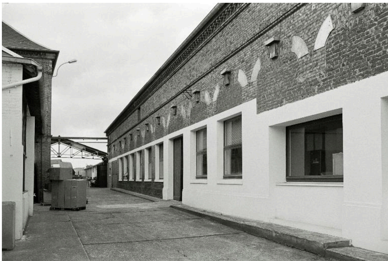
Elévation ouest de l'atelier de fabrication est, en 1990.
