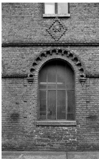
Atelier de fabrication est, élévation est : détail, en 1990. Phot. Francis Dubuc IVR22_19908000151Z
