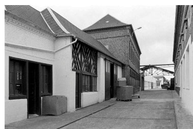
Vue partielle de l'atelier de fabrication, en 1990. Phot. Francis Dubuc IVR22_19908000147Z
