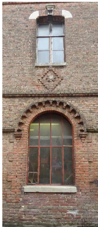
Détail des baies de l'atelier de fabrication. Phot. Frédéric-Nicolas Kocourek IVR32_20168005527NUCA
