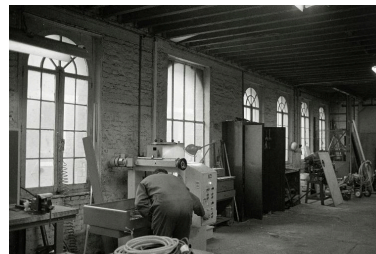
Vue intérieure de l'atelier de fabrication, en 1990. Phot. Francis Dubuc IVR22_19908000157Z
