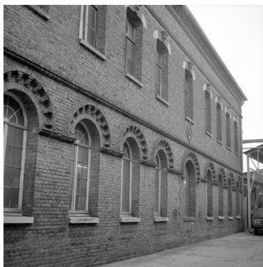
Atelier de fabrication est, élévation ouest, en 1990. Phot. Francis Dubuc IVR22_19908000473X
