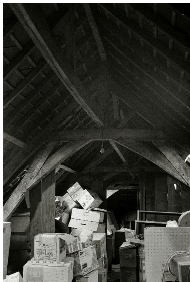
Vue intérieure des combles, en 1990. Phot. Francis Dubuc IVR22_19908000160Z
