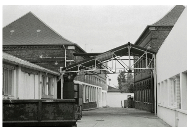
Vue partielle de l'atelier de fabrication, en 1990. Phot. Francis Dubuc IVR22_19908000158Z
