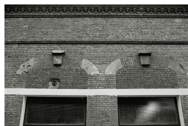
Détail de baies de l'atelier de fabrication, en 1990. Phot. Francis Dubuc IVR22_19908000154Z
