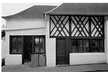
Vue partielle de l'atelier de fabrication, en 1990. Phot. Francis Dubuc IVR22_19908000148Z
