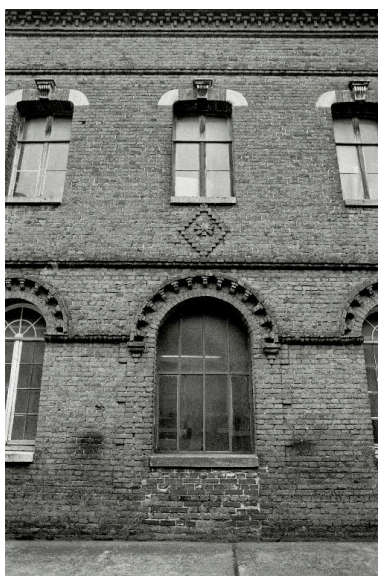
Détail de baies de l'atelier de fabrication, en 1990. Phot. Francis Dubuc IVR22_19908000150Z
