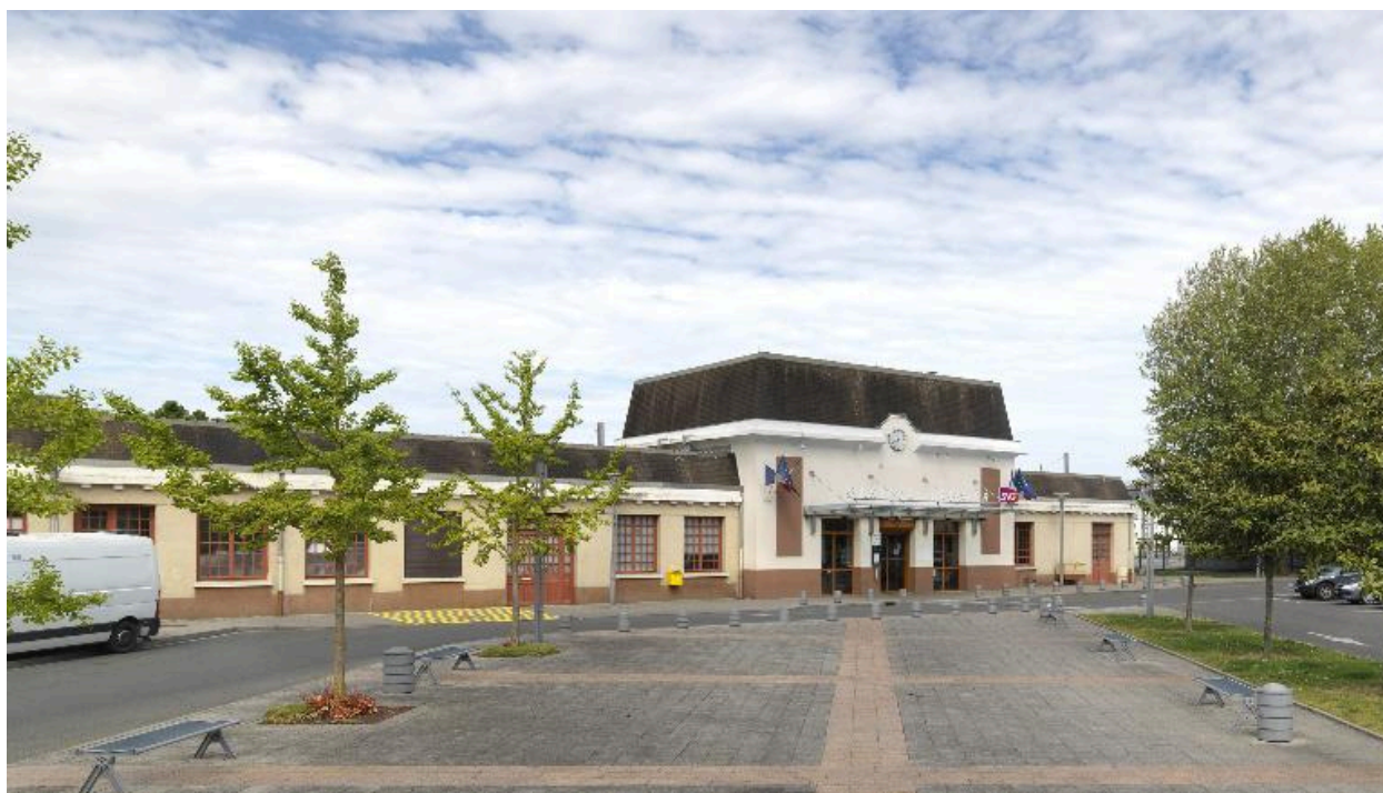
Vue générale, façade principale.
