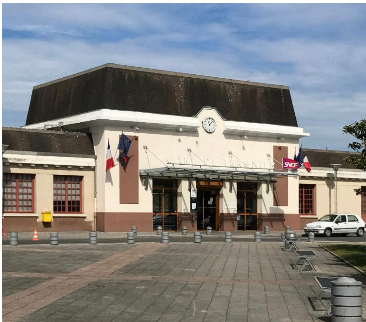
Entrée principale de la gare de voyageurs.
