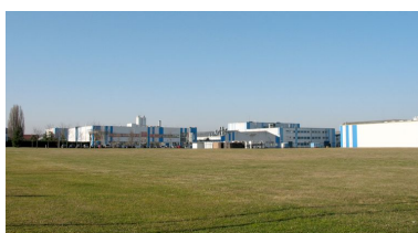
Vue générale des ateliers aujourd'hui. Phot. Clarisse Lorieux IVR22_20086005196NUCA
