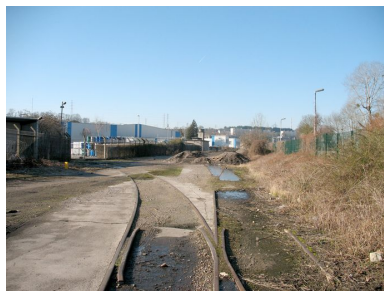
Réseaux de voies ferrées desservant l'usine. Phot. Clarisse Lorieux IVR22_20086005201NUCA
