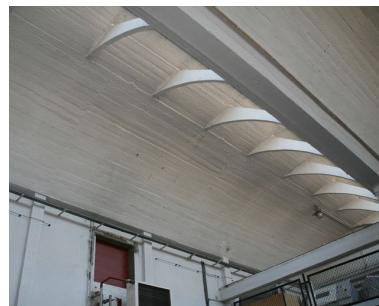
Détail de la structure des sheds paraboliques construits par Perret. Phot. Clarisse Lorieux IVR22_20086005203NUCA
