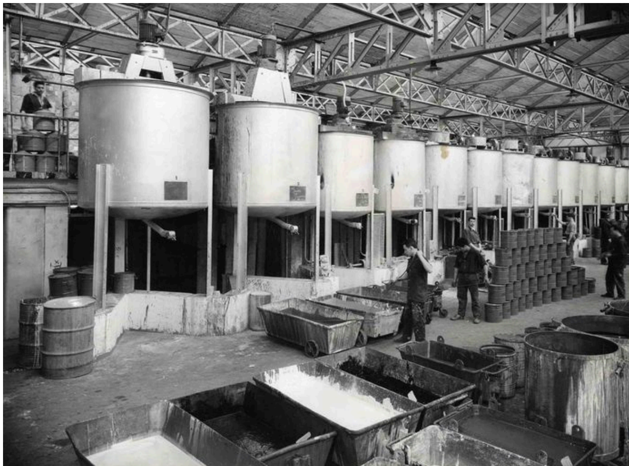
Cuves à mélanges vers 1950 (archives d'entreprise).
