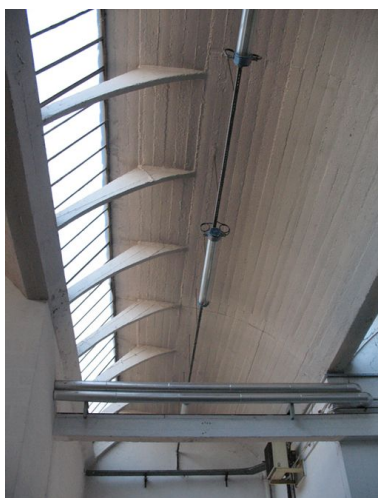
Détail d'une travée des sheds. Phot. Clarisse Lorieux IVR22_20086005205NUCA
