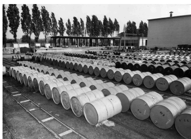
Parc à fûts et quai des solvants, vers 1950 (archives d'entreprise). Phot. Clarisse Lorieux IVR22_20086005193NUCAB
