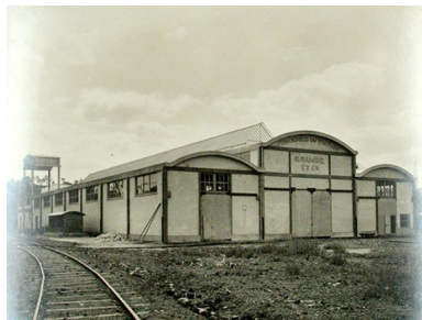
Ateliers de la fonderie construits par les architectes Perret, décennie 1920 (IFA ; 535AP651/5). Phot. Clarisse Lorieux IVR22_20076005543NUCAB
