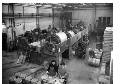
Un atelier de broyeurs à billes, vers 1950 (archives d'entreprise). Phot. Clarisse Lorieux IVR22_20086005189NUCAB
