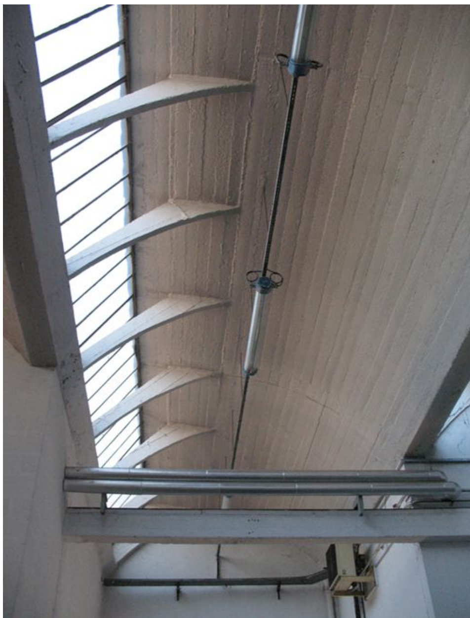
Détail d'une travée des sheds.
