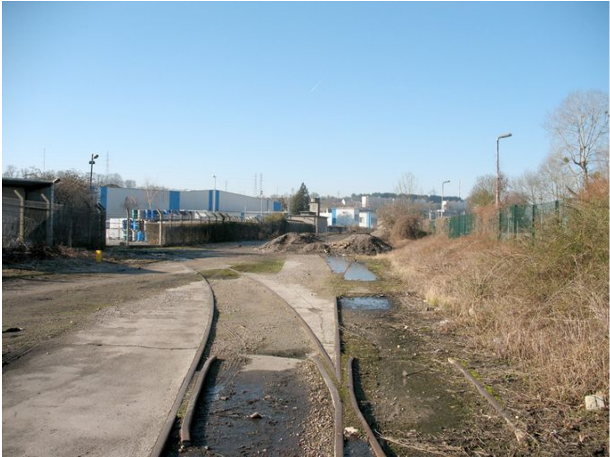
Réseaux de voies ferrées desservant l'usine.
