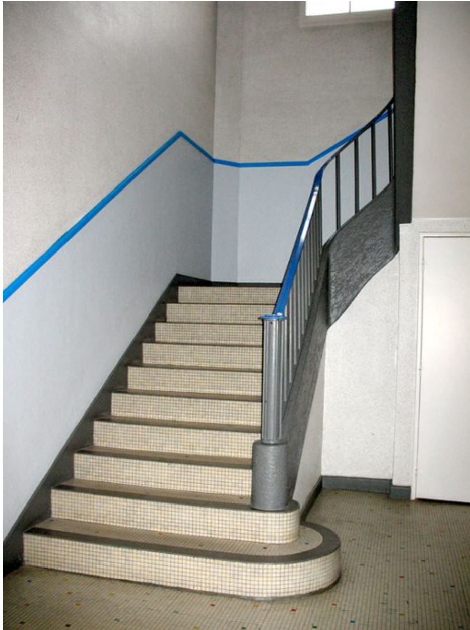
Départ de l'escalier menant aux anciens bureaux.
