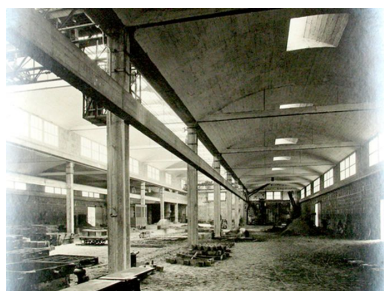
Intérieur de la fonderie : ateliers latéraux (IFA ; 535AP651/5). Phot. Clarisse Lorieux IVR22_20076005546NUCAB
