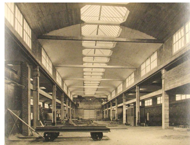
Intérieur de la fonderie : nef centrale (IFA ; 535AP651/5). Phot. Clarisse Lorieux IVR22_20076005545NUCAB
