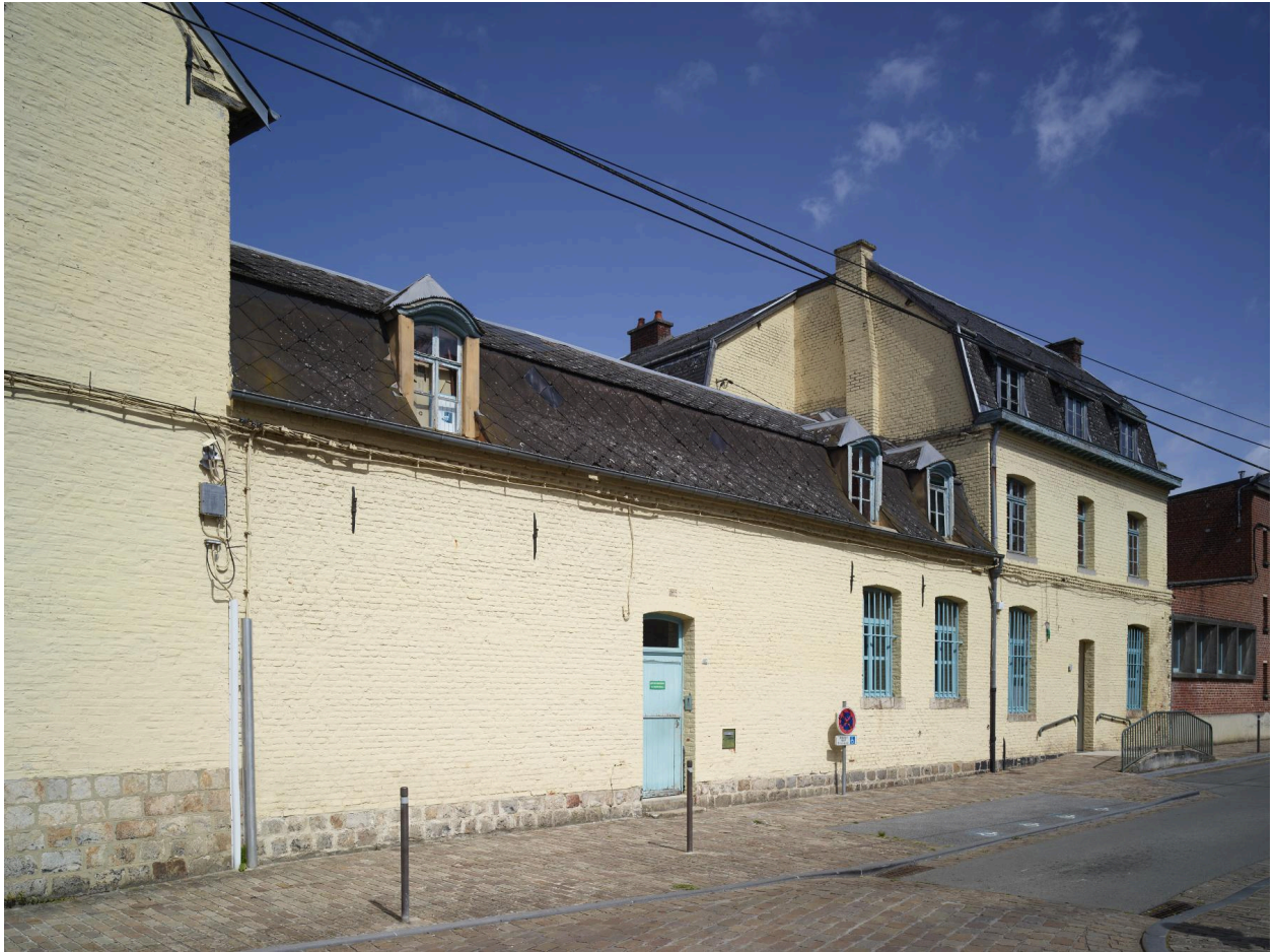
Vue générale de la façade rue Chevray. Vue orientée ouest/est.
