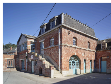
Vue de la façade arrière du pavillon en retour d'équerre de l'aile sur la rue Chevray, depuis la cour de l'école primaire Chevray. Vue orientée sud-ouest/nord-est. Phot. Pierre Thibaut IVR32_20255900170NUCA
