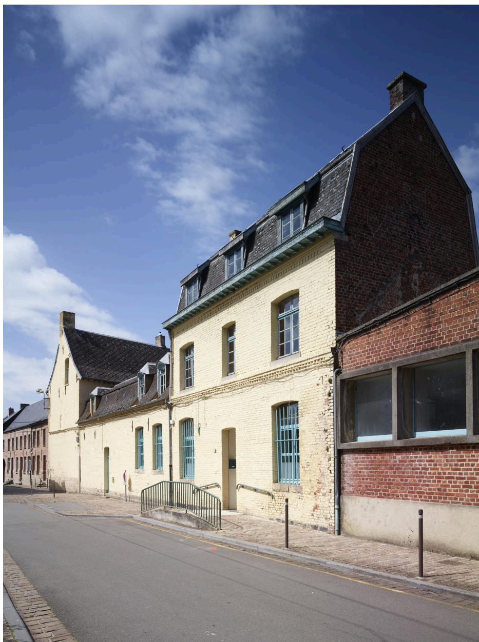
Vue générale de la façade rue Chevray. Vue orientée est/ouest.
