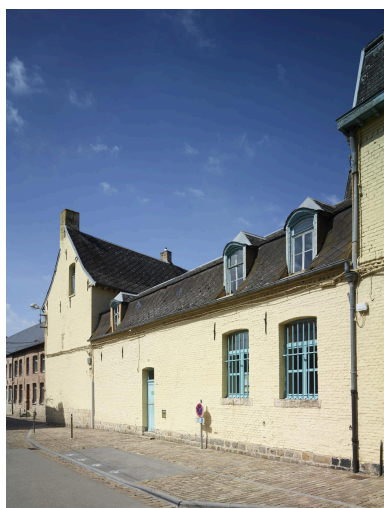
Détail de la partie ouest de la façade rue Chevray. Vue orientée est/ouest. Phot. Pierre Thibaut IVR32_20245900084NUCA
