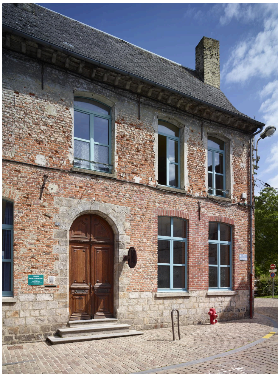
Détail de la partie droite de la façade rue de la Couronne.
