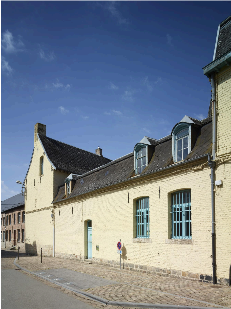
Détail de la partie ouest de la façade rue Chevray. Vue orientée est/ouest.
