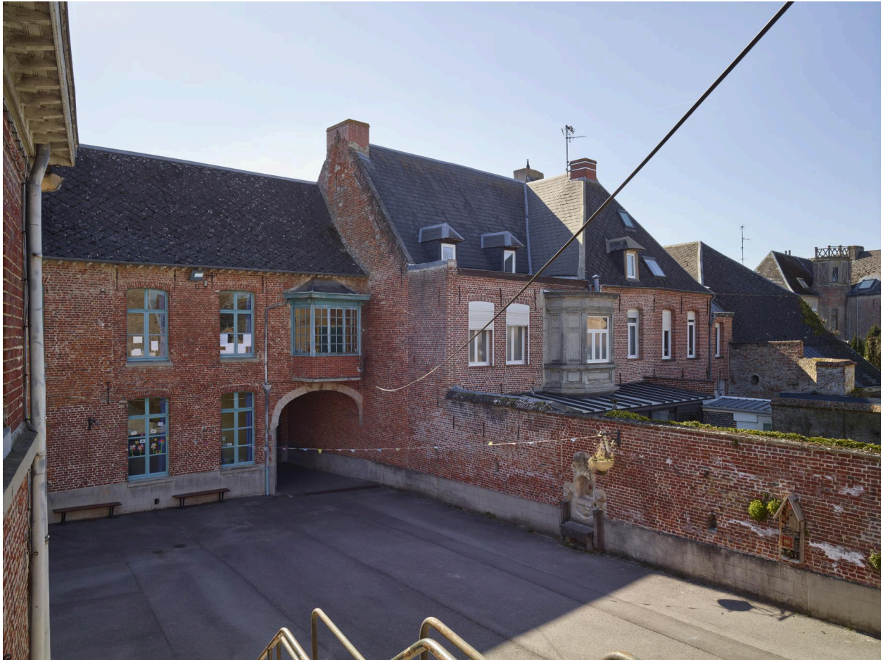
Vue de la partie nord-ouest de la façade arrière de l'aile principale sur la rue de la Couronne, depuis la cour de l'école primaire Chevray. Vue orientée nord-est/sud ouest.
