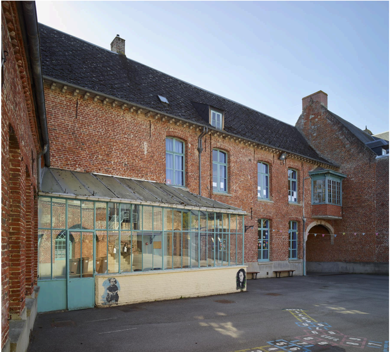
Vue de la façade arrière de l'aile principale sur la rue de la Couronne, depuis la cour de l'école primaire Chevray. Vue orientée sud/nord.
