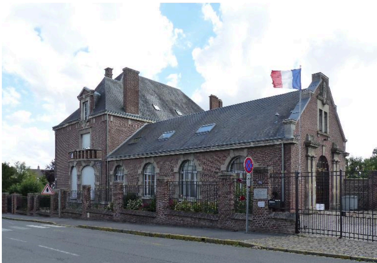
Vue depuis le nord.
