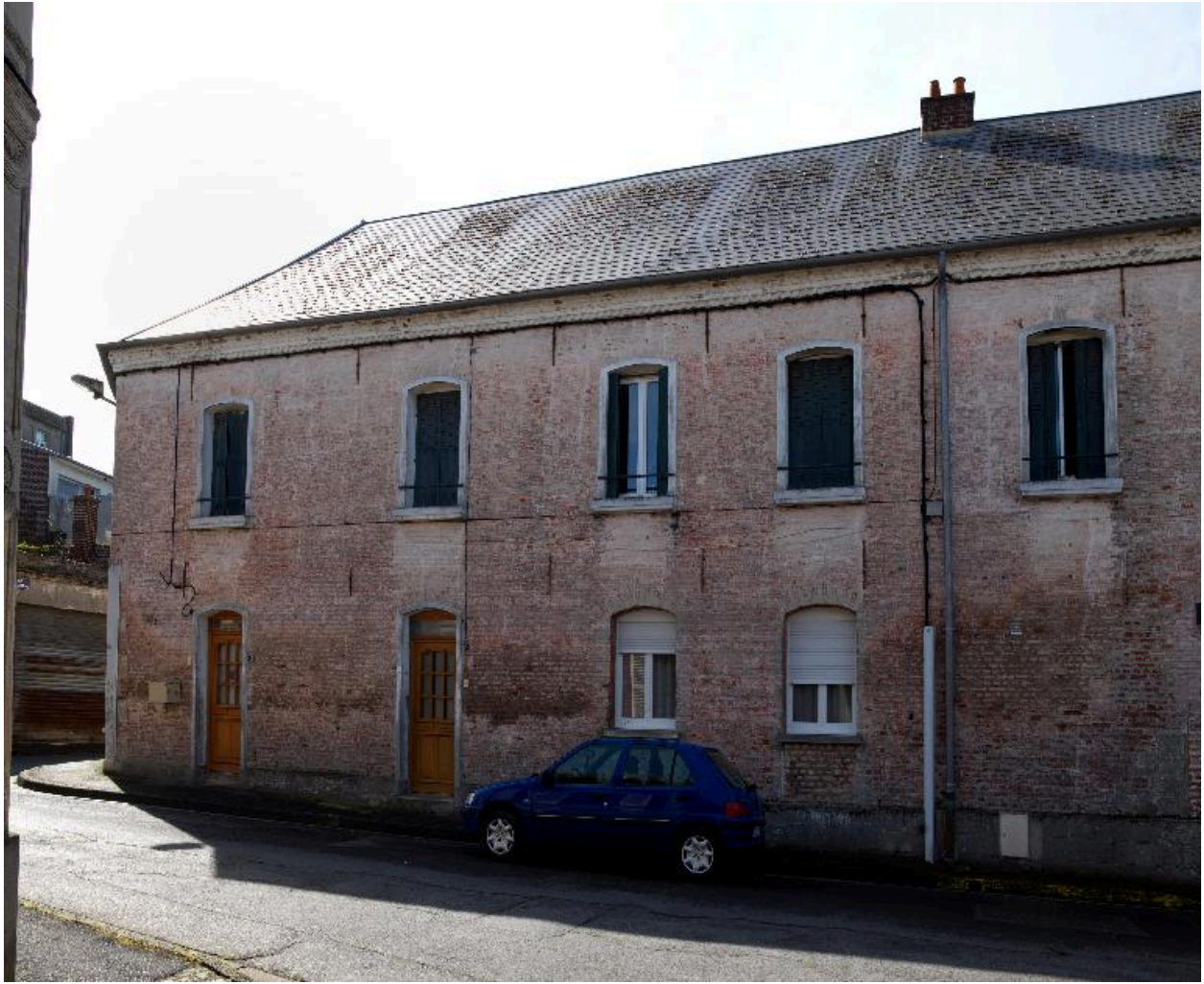
Vue de la façade sud.
