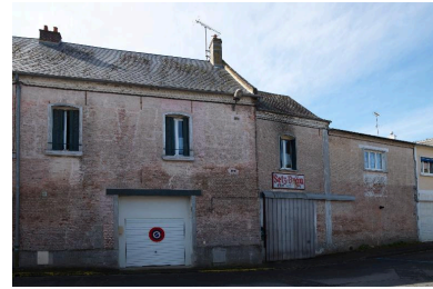
Vue de la partie est de la façade sud. Phot. Marie-Laure Monnehay-Vulliet IVR32_20168000119NUC2A
