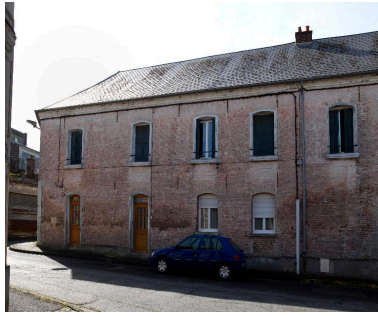
Vue de la façade sud.
